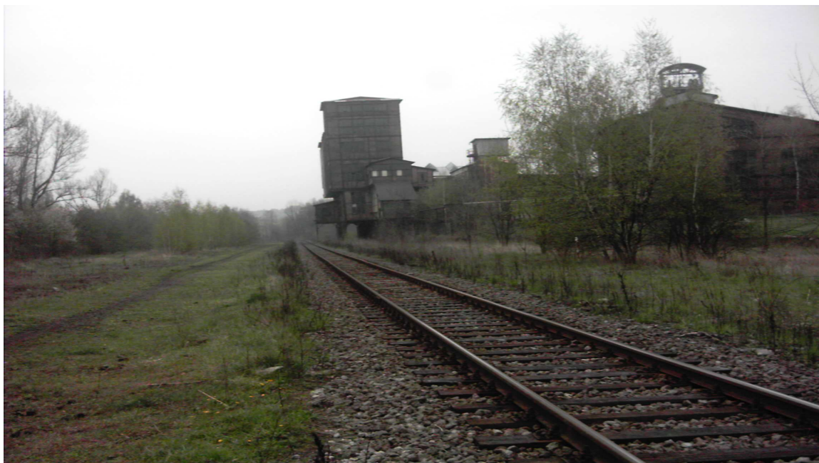
Obrázek 17: Fotografie zachycující současný stav stanice Michálkovice
