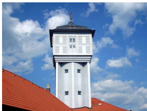
Obr. 51 Vodojem v Josefově
