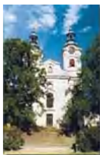
Obr. 27: kostel Sv. kříže
