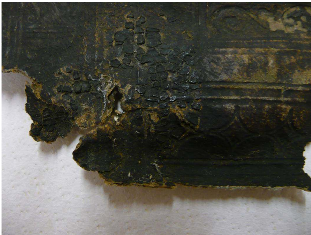
Obr.62. Pohled na poškození usně, detail
