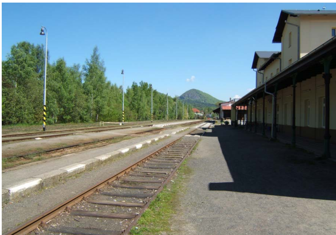
Obr. 4 Pohled na stávající stav nástupních ploch ve stanici.
