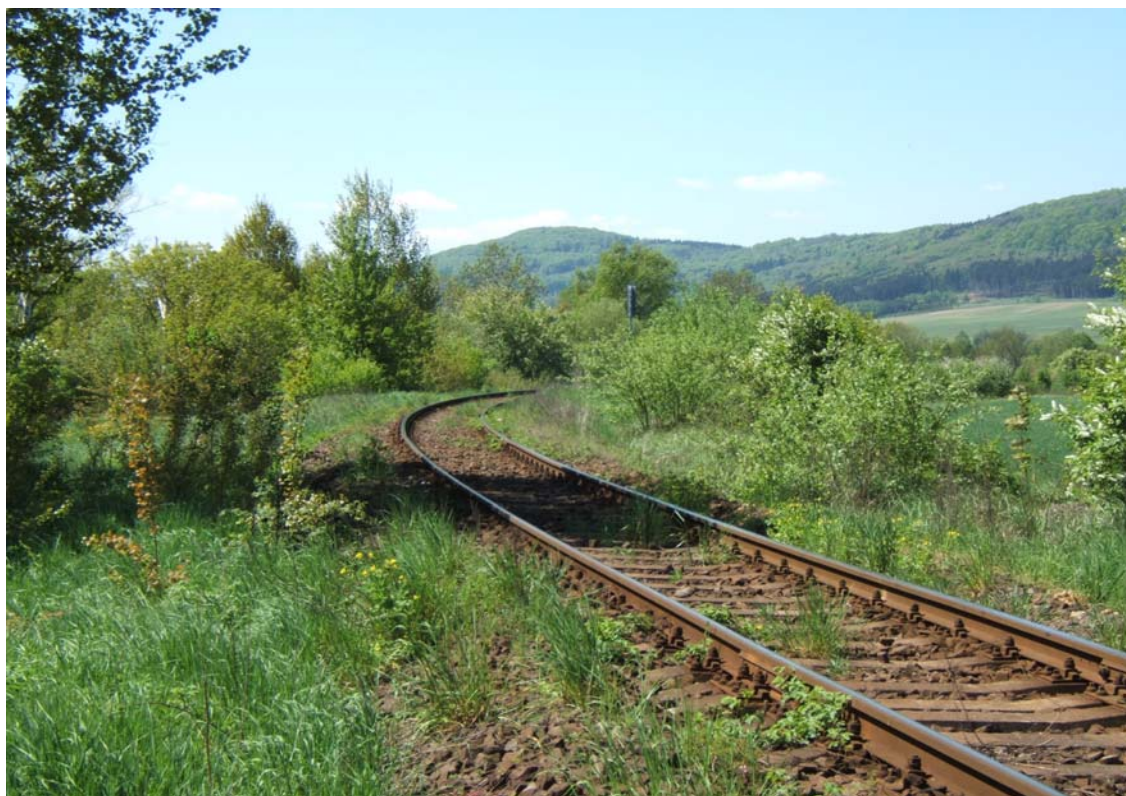
Obr. 16 Pohled na navazující oblouk širé trati ve směru na Skalici u České Lípy.
