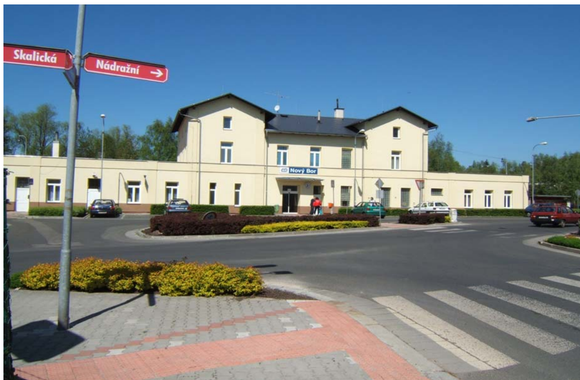
Obr. 1 Pohled na výpravní budovu s přednádražím.
