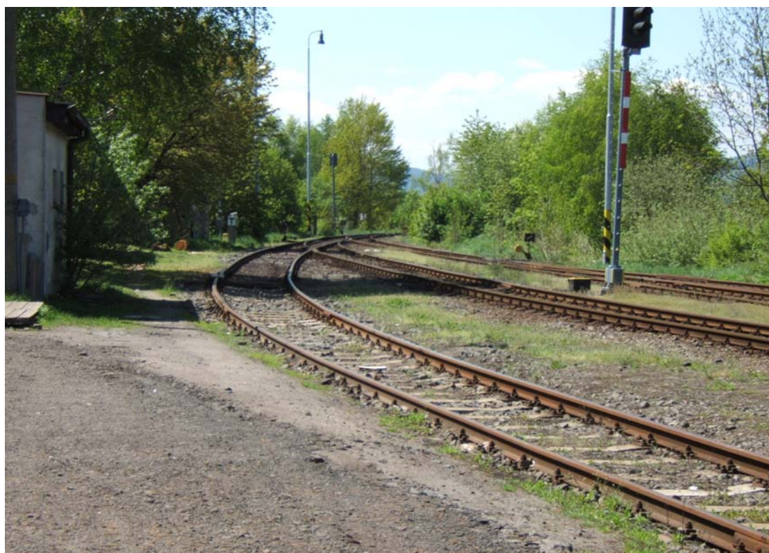
Obr. 18 Pohled na výhybku č. 2 skalického zhlaví.
