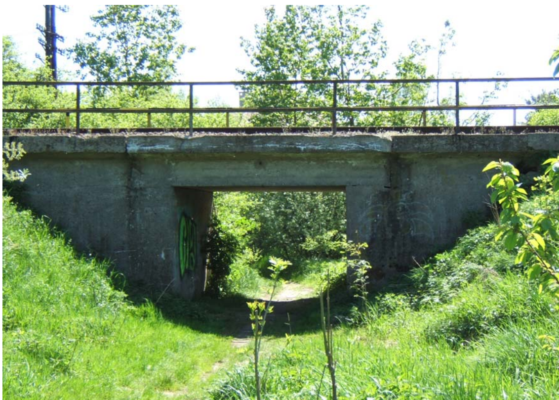
Obr. 17 Mostní objekt č. 025133 v km 56,725.
