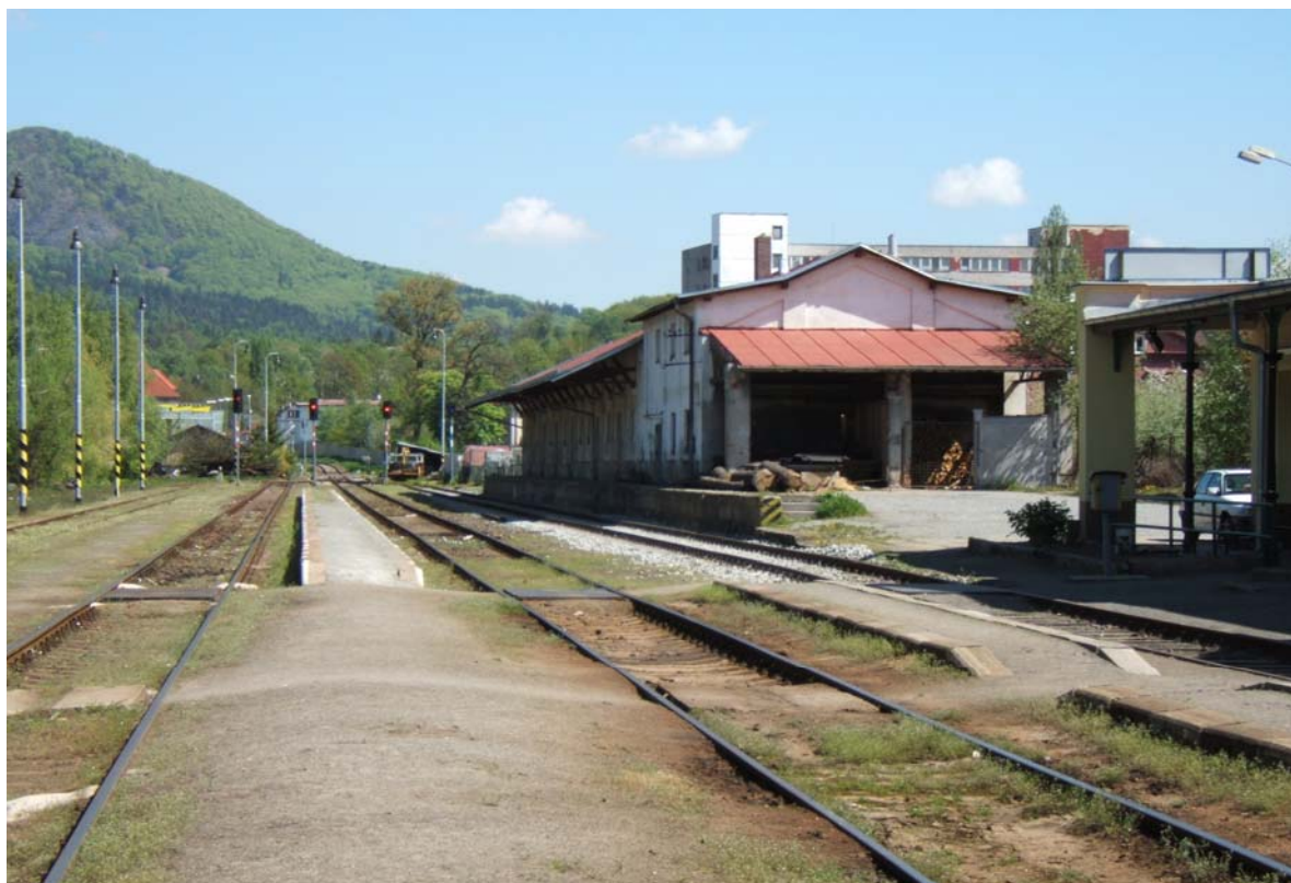
Obr. 5 Boční rampa se skladištěm u koleje č. 2.
