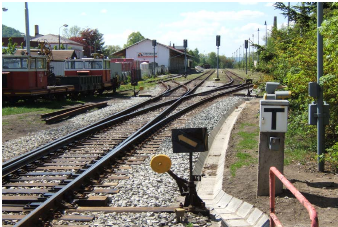
Obr. 10 Pohled na svorské zhlaví
