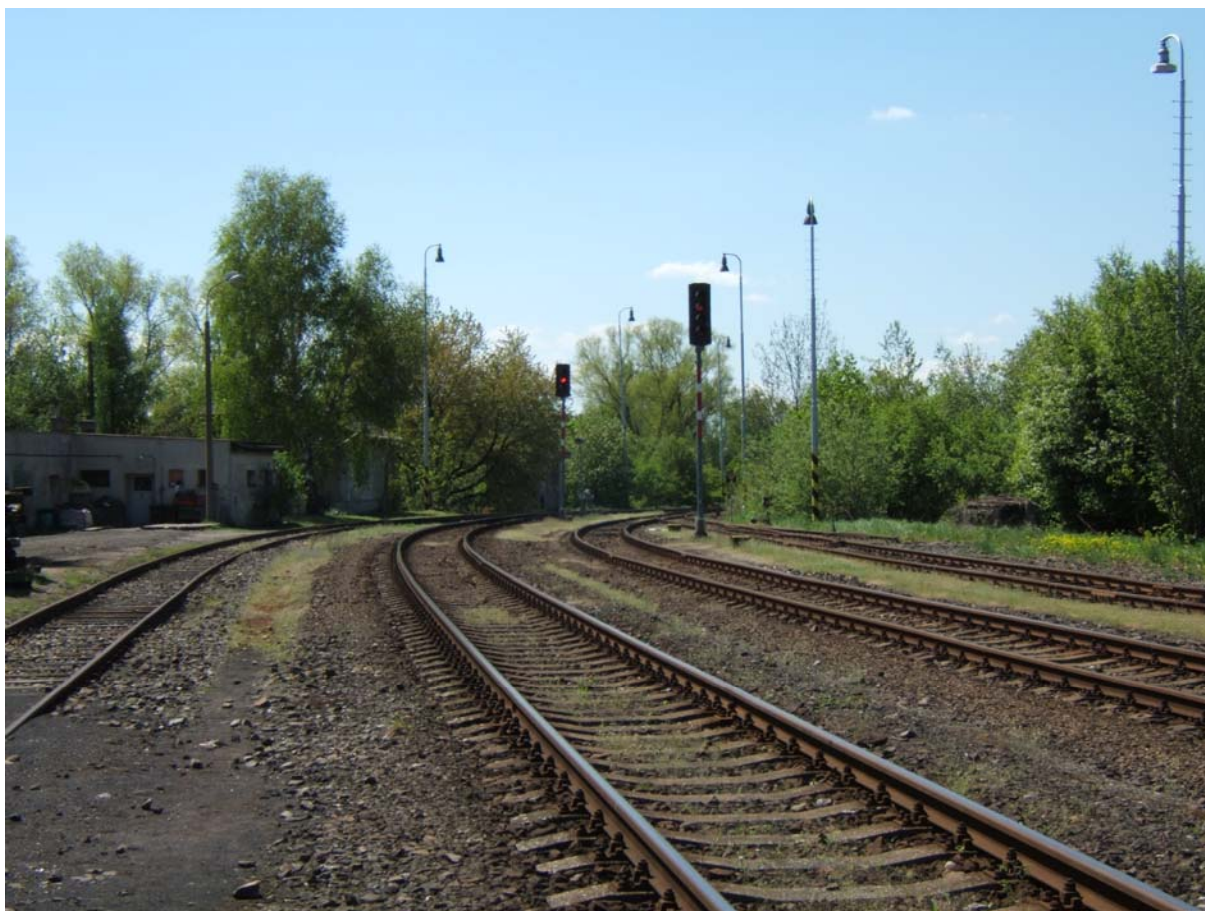
Obr. 19 Pohled na vjezd do skalického zhlaví z koleje č. 1.
