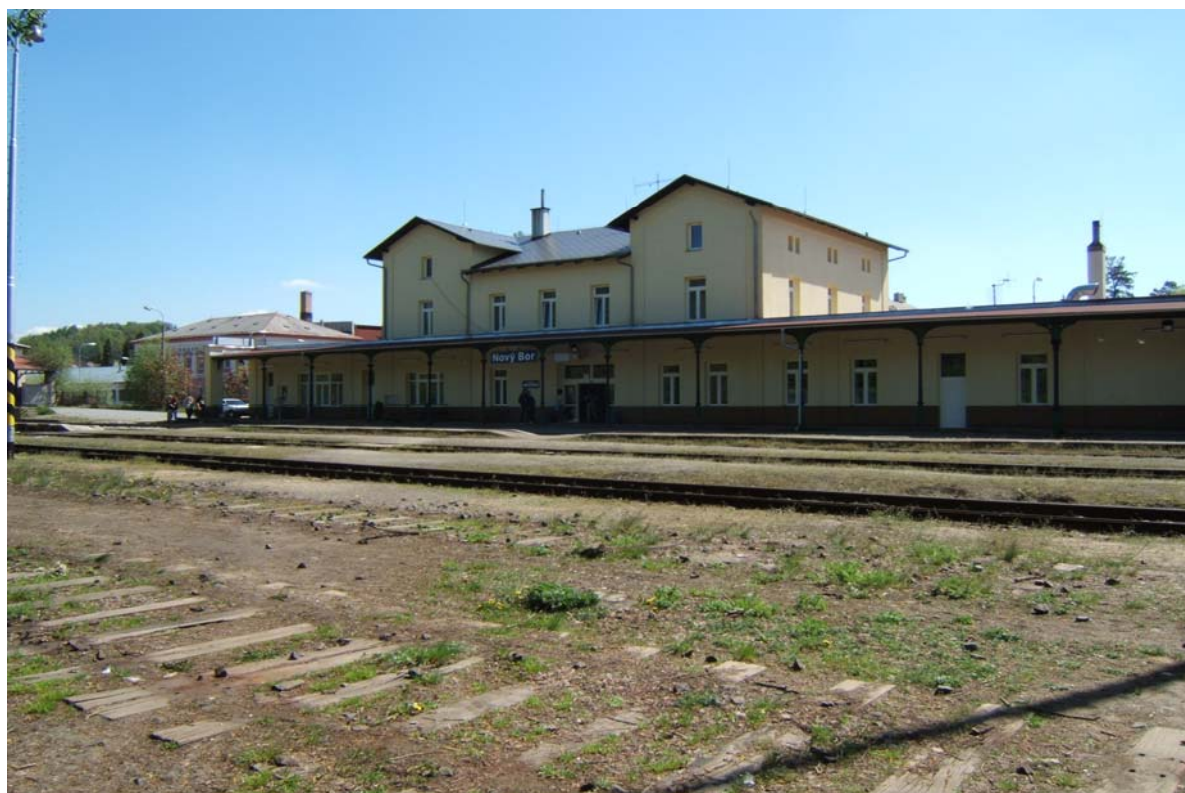
Obr. 2 Pohled na kryté nástupiště výpravní budovy.
