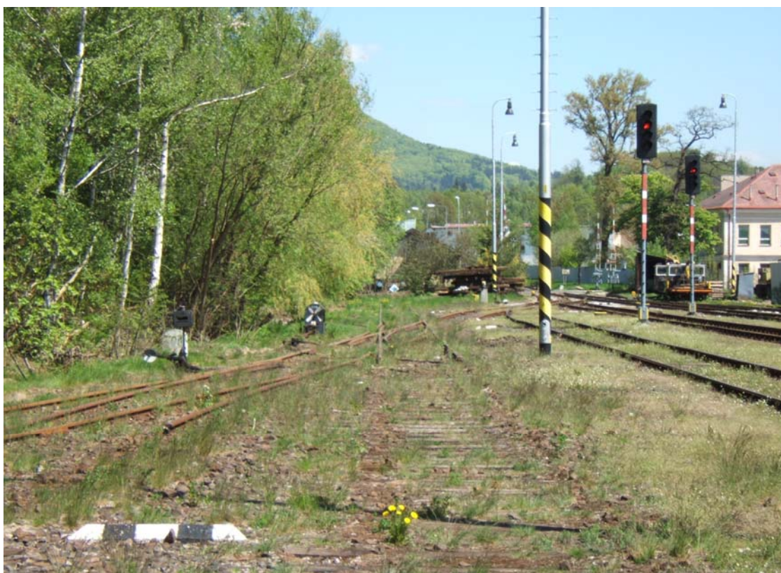
Obr. 14 Odvratná kolej pro vozy na vlečkových kolejích.
