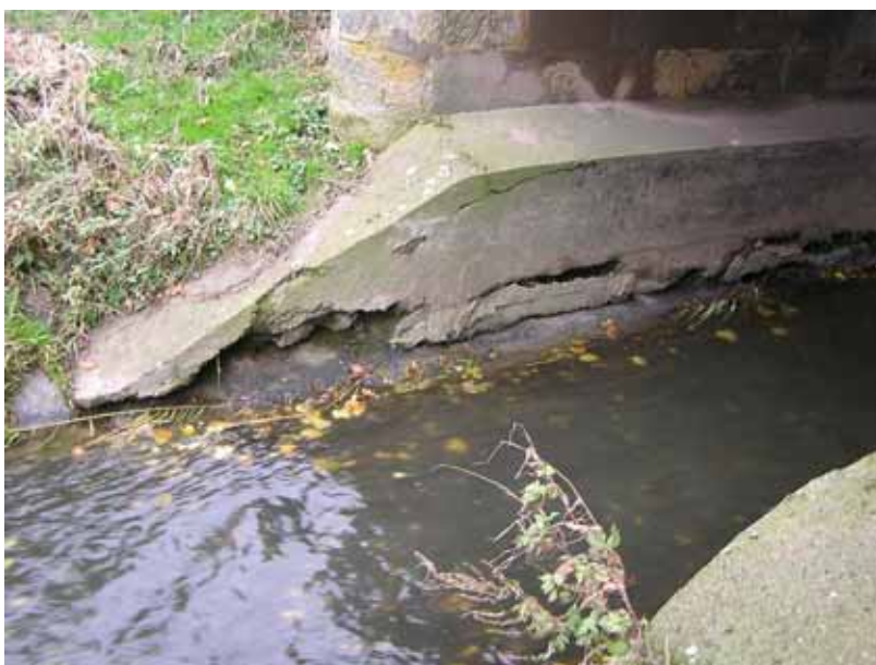
Číslo obrázku : 14 , Betonová obezdívka pilíře vlevo na straně výtoku
