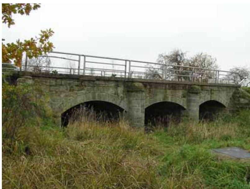
Číslo obrázku : 5 , Pohled do levého inundačního pole mostu ze strany vtoku Popis poruch: Nános bahna do prostoru na kamenné dlažbě , na straně výtoku bahno porostlé trávou vytváří překážku plynulého odvodnění z inundačního pole. Na opěře a pilíři je patrná vlhkost prostupující z horních vrstev nad klenbou.
