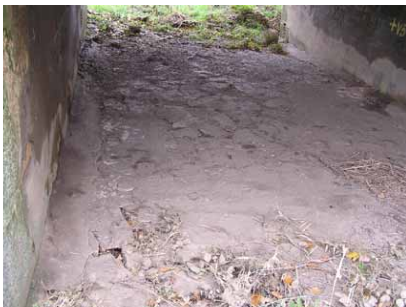
Číslo obrázku : 5 , Pohled do levého inundačního pole mostu ze strany vtoku Popis poruch: Nános bahna do prostoru na kamenné dlažbě , na straně výtoku bahno porostlé trávou vytváří překážku plynulého odvodnění z inundačního pole. Na opěře a pilíři je patrná vlhkost prostupující z horních vrstev nad klenbou.
