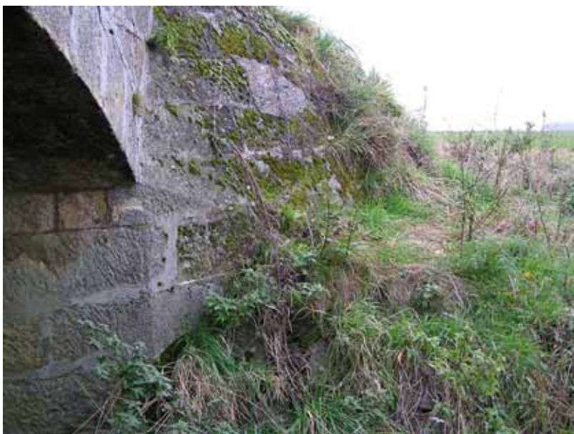
Číslo obrázku : 13 , Opěra mostu napravo u výtoku Popis poruch: Velký nános bláta, nadměrná vegetace
