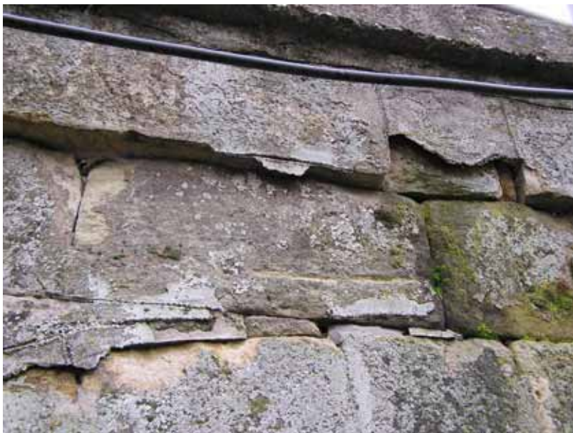
Číslo obrázku : 14 , Detail římsy s čelním zdivem na straně výtoku
