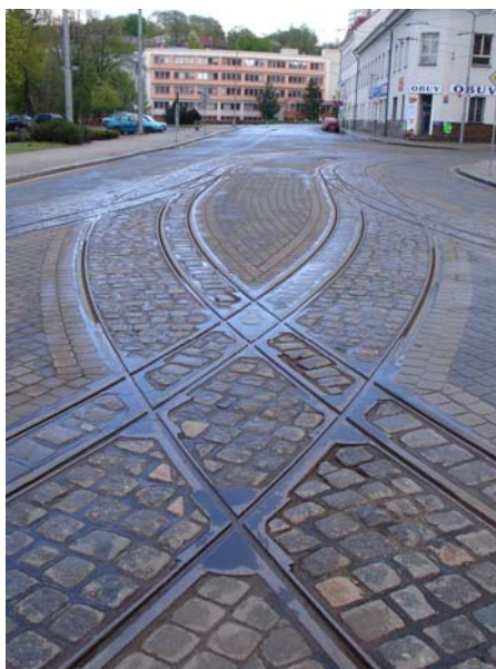
Obrázek 2: Křížení kolejové splítky rozchodů (Rybniček)
