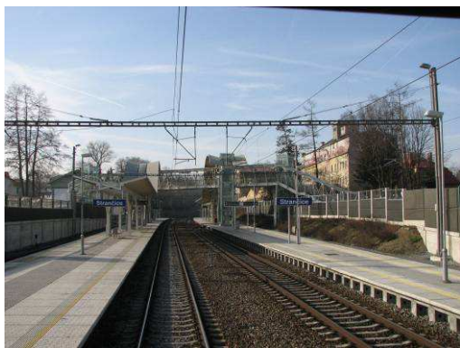
Obr.5: Rekonstruované nádraží Strančice Zdroj: autor
