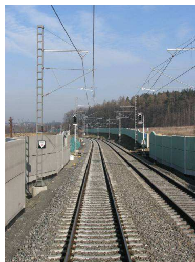
Obr.3: Protihlukový „tunel“ u Světic Zdroj: autor
