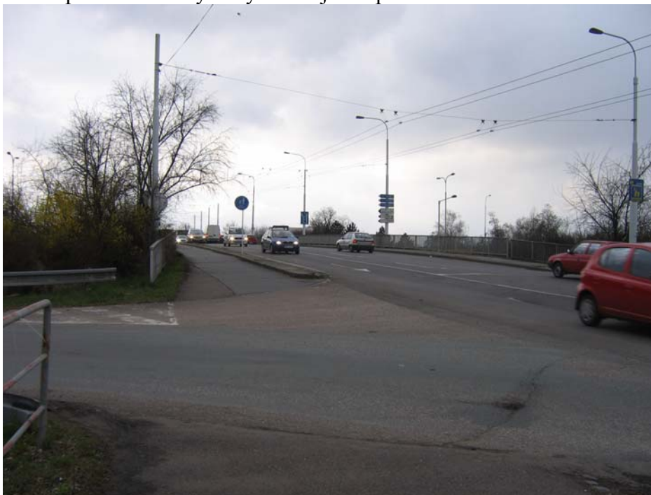
Obr. 9 – Přechod pro chodce a cyklisty na nadjezdu přes silnici č. 1/37
