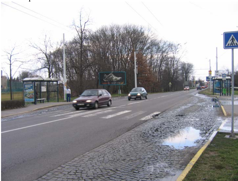
Obr. 10 – Přechod pro chodce mezi zastávkami MHD Globus
