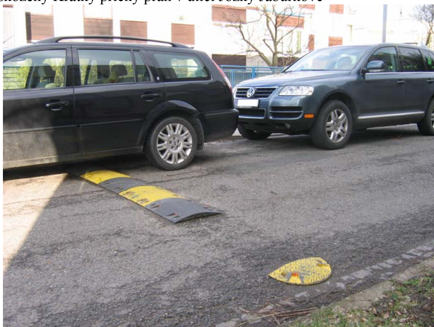
Obr. 2 – Poškozený Krátký příčný práh v ulici Jožky Jabůrkové
