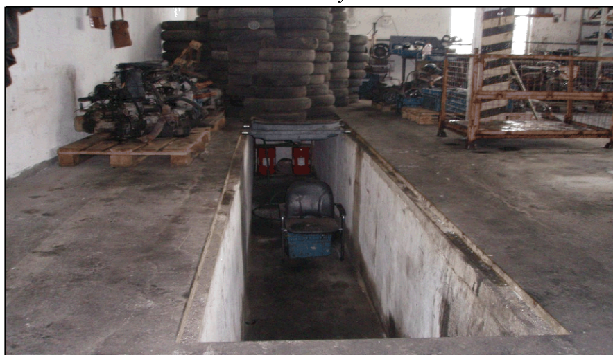
Obr. 17 - Pracoviště 1 → demontážní jáma
