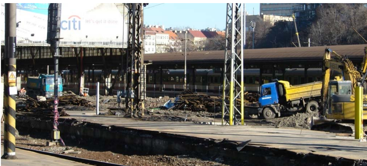
Obrázek 5: Vyluka části stanice Praha hl. n.
