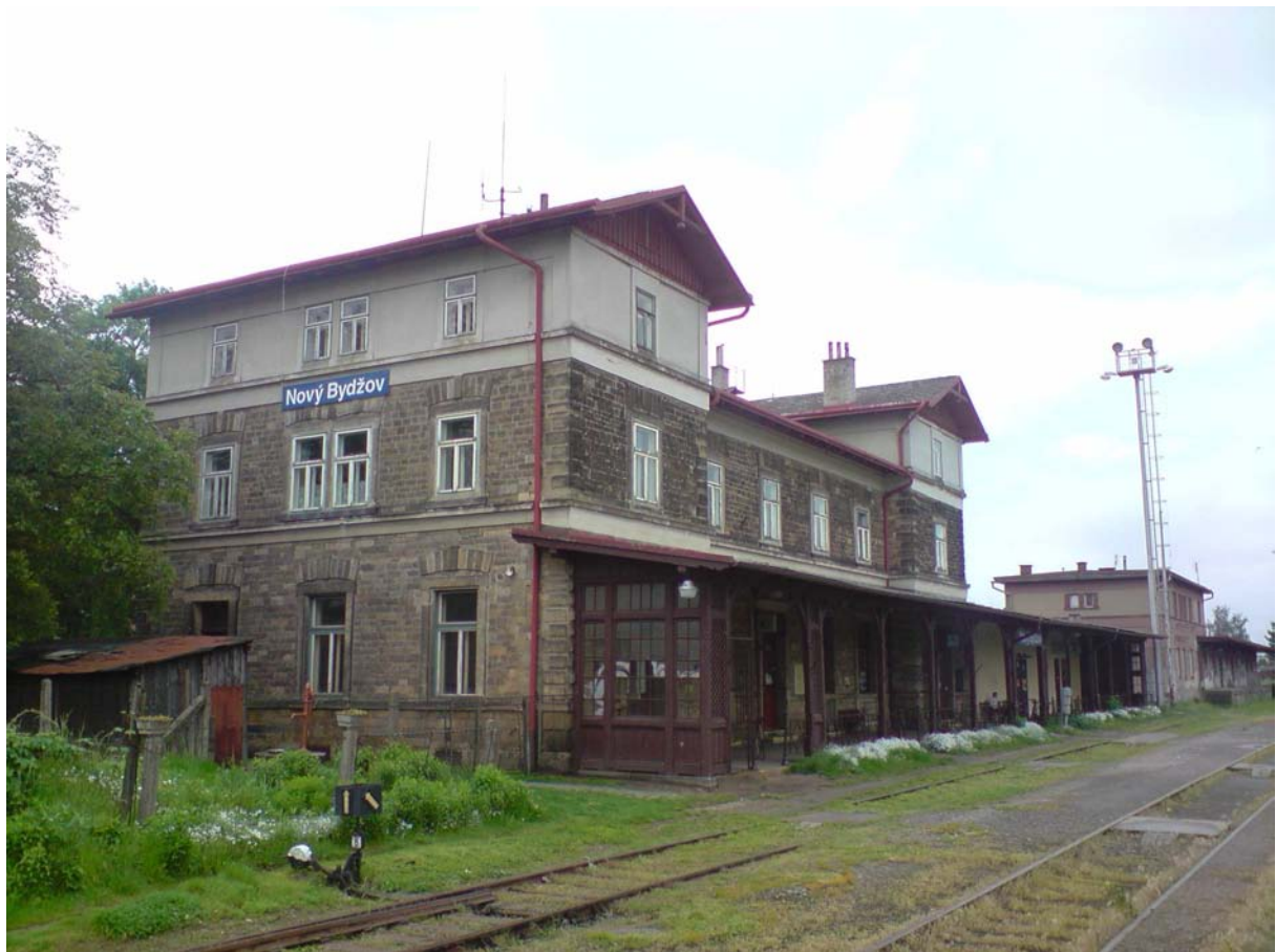
Pohled na výpravní budovu z nástupiště
