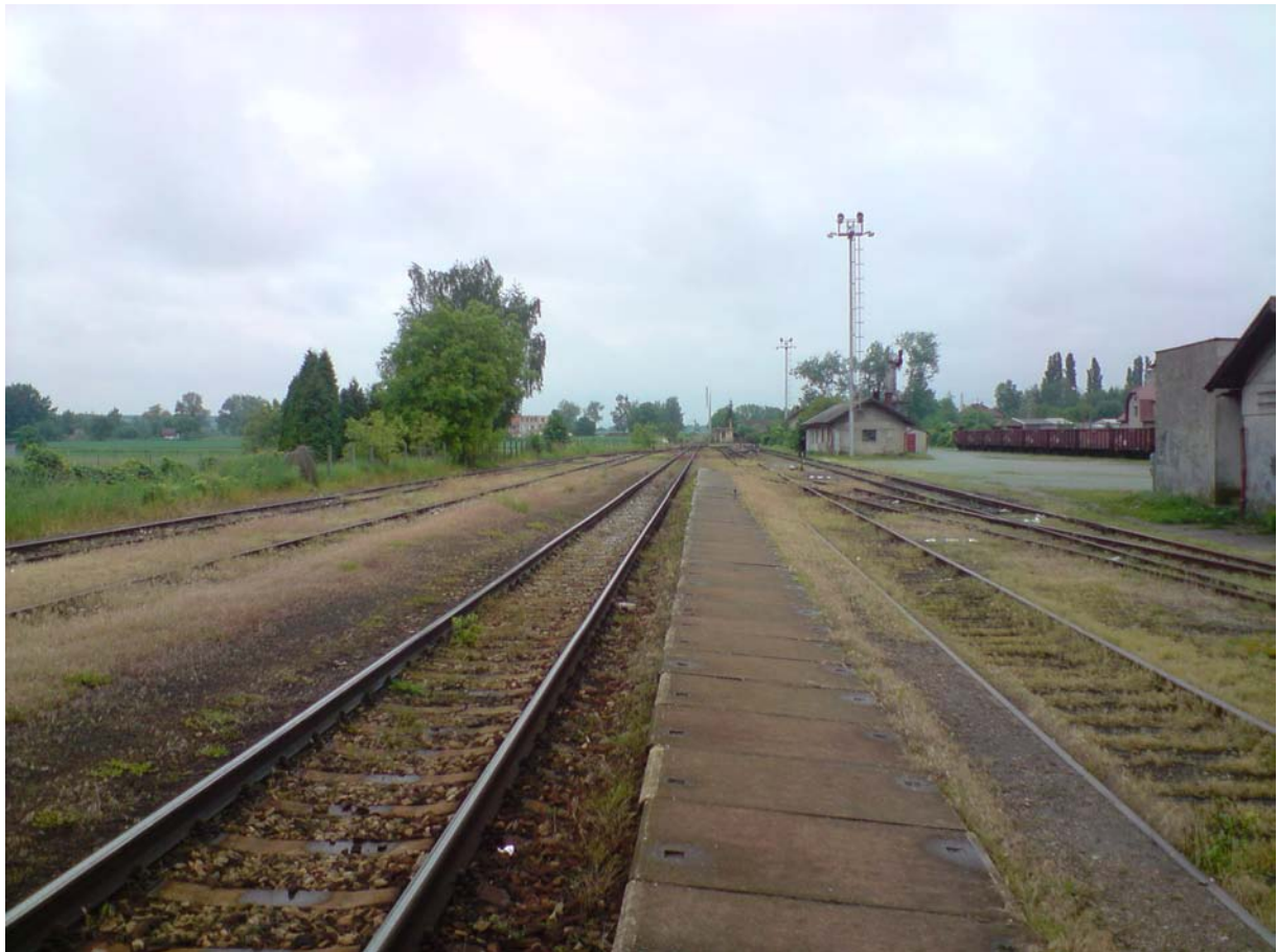
Severní pohled na stanici z nástupiště
