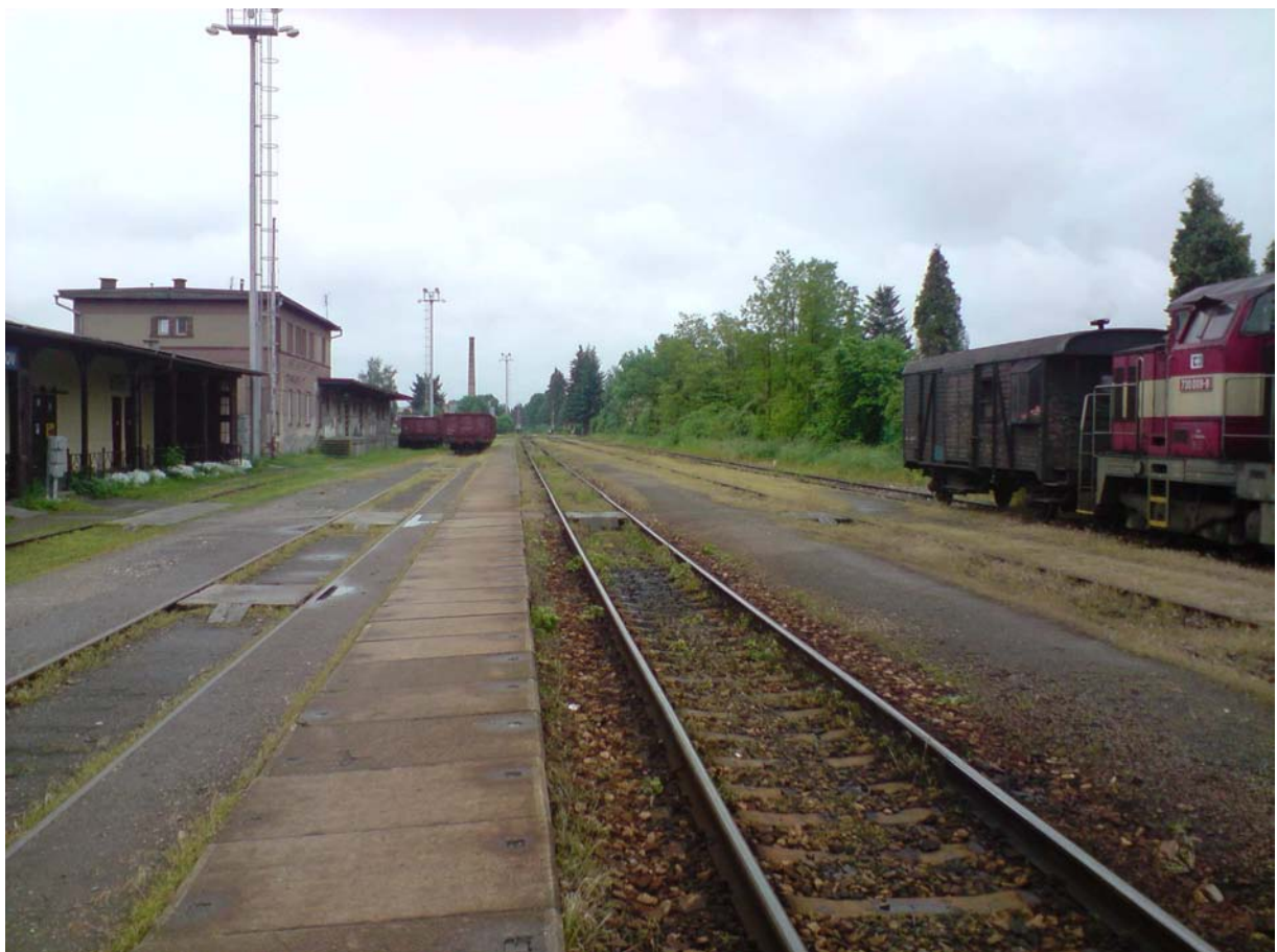
Jižní pohled z nástupiště u hlavní dopravní koleje
