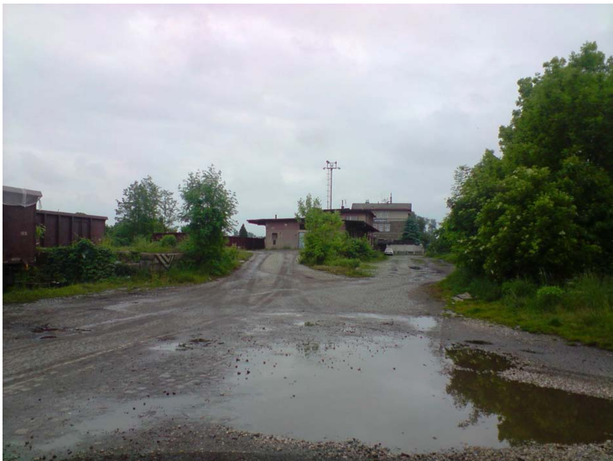
Severní pohled na stávající rampu se skladištěm
