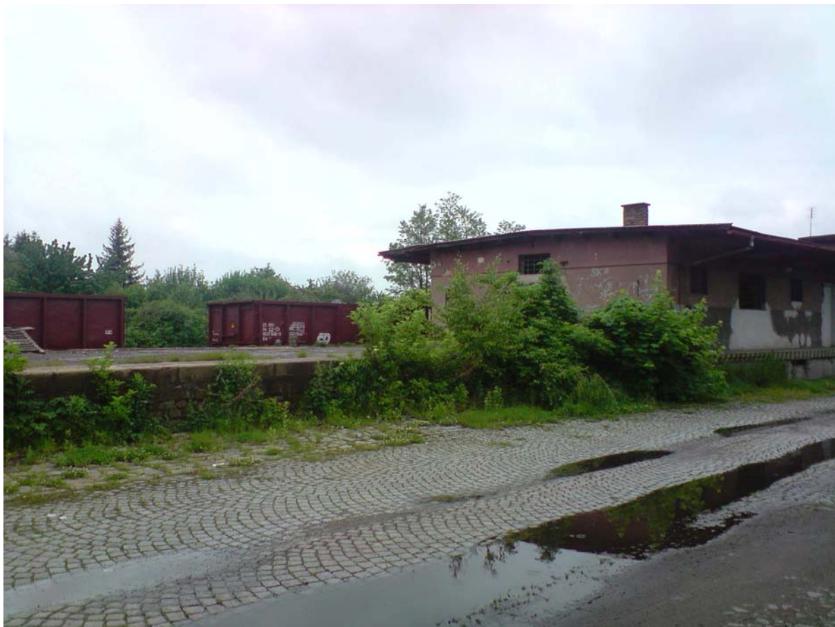
Severozápadní pohled na rampu se skladištěm
