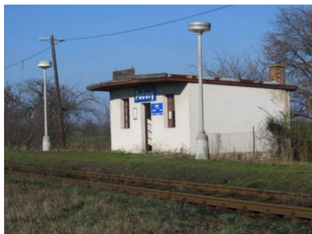
Celkový pohled na stanoviště
