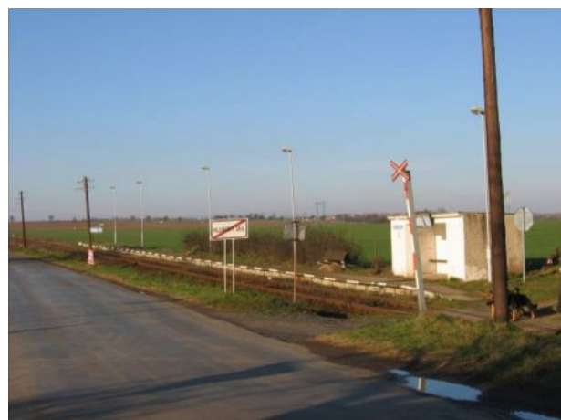
Celkový pohled na stanoviště
