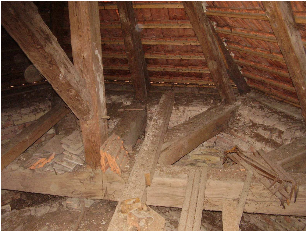
Obr. 80 - Vějířovité uspořádání vazných trámů a krokví ve krovu nad presbytářem.
