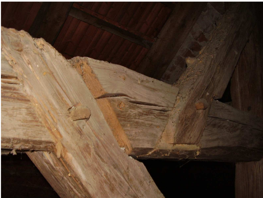
Obr. 81 - Rybinový plátový spoj jištěný dřevěnými kolíky.
