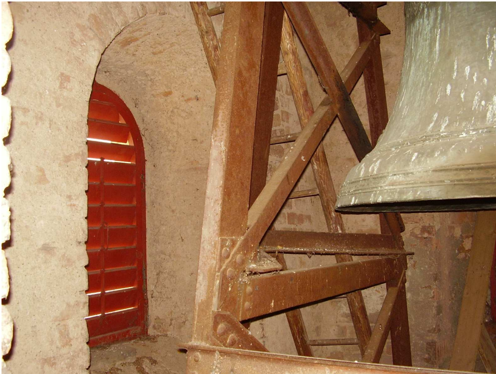
Obr. 68 - Pohled na část ocelové zvonové stolice ve 3. patře.
