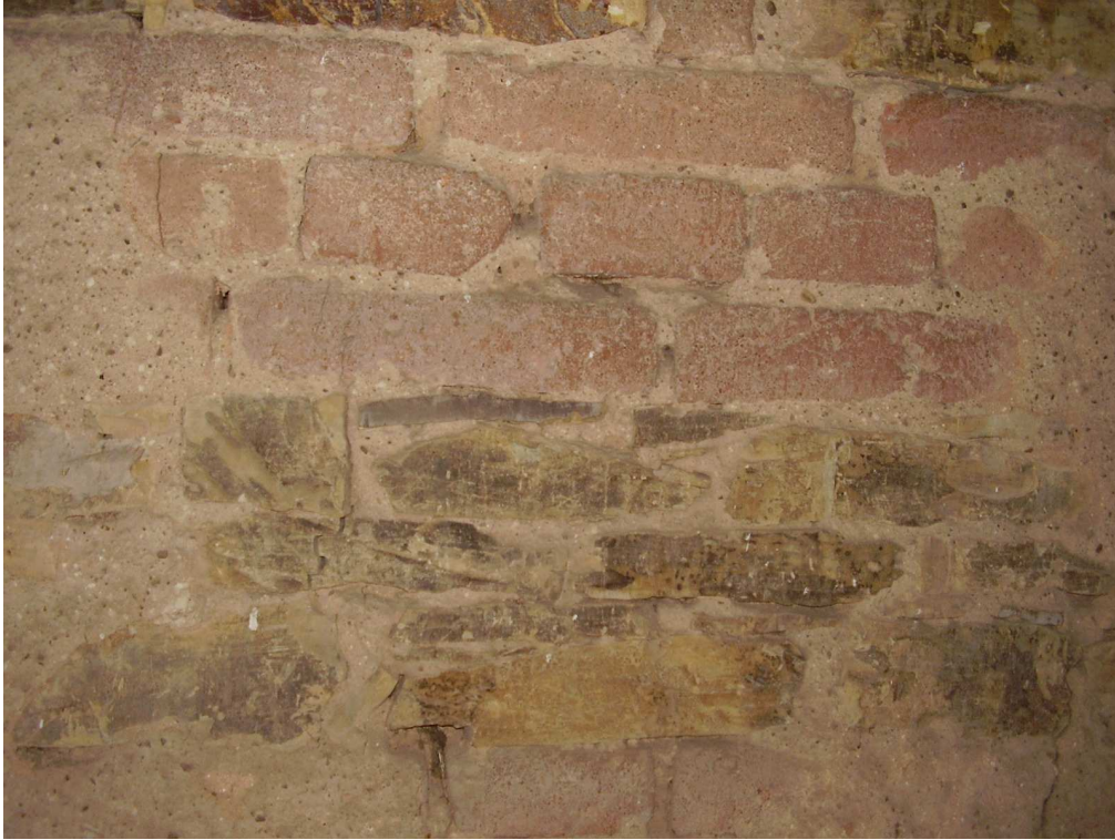
Obr. 70 - Kombinace cihlového a opukového zdiva ve věži kostela.
