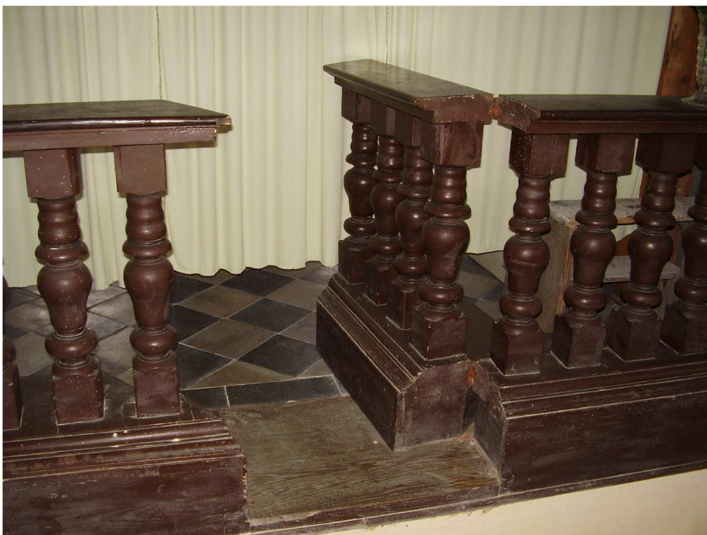
Obr. 63 - Soustružené barokní kuželky oddělující prostor oratoře od presbytáře.
