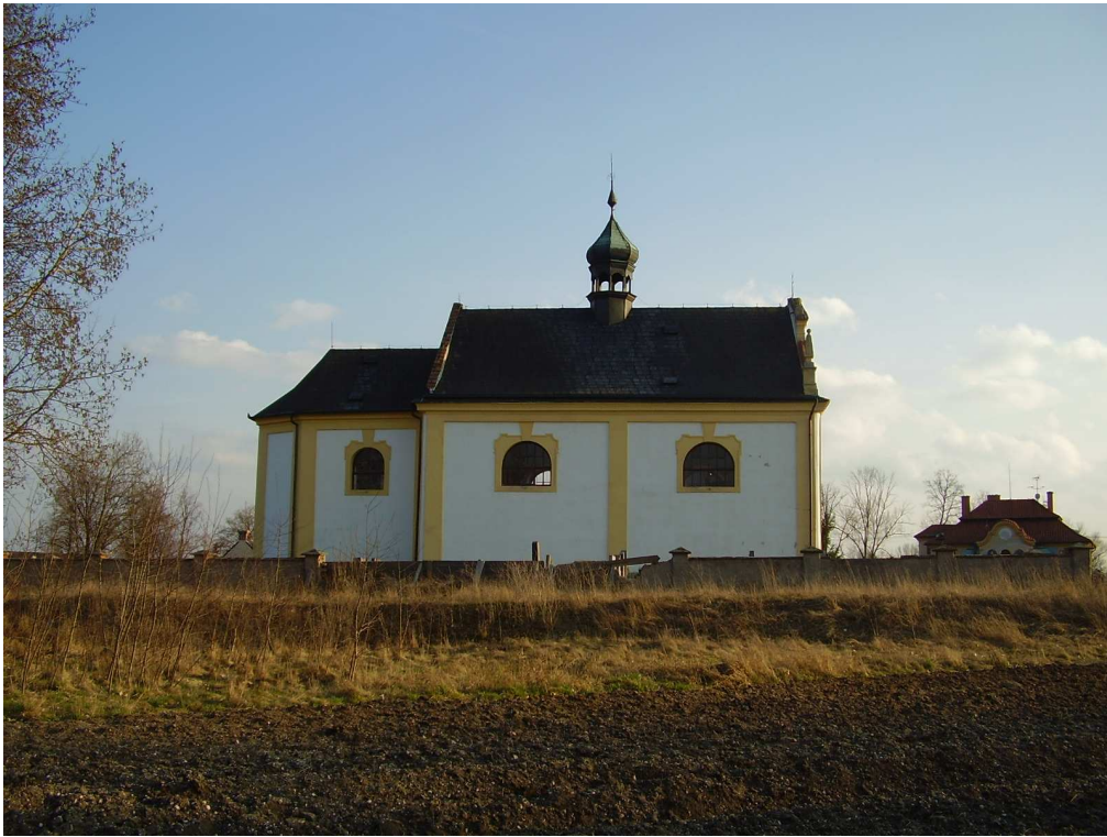
Obr. 24 - Severní průčelí kostela sv. Benedikta.
