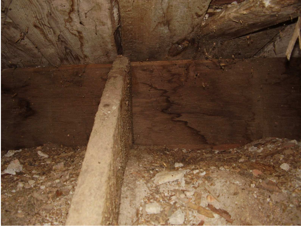
Obr. 76 - Pohled do konstrukce stropu s příčným a segmentově vybraným trámem.
