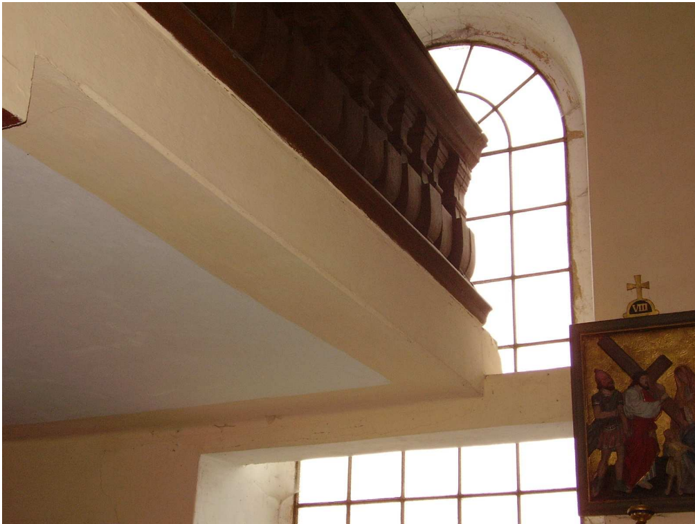
Obr. 62 - Postranní ocelová traverza zajišťující stabilitu tribuny.
