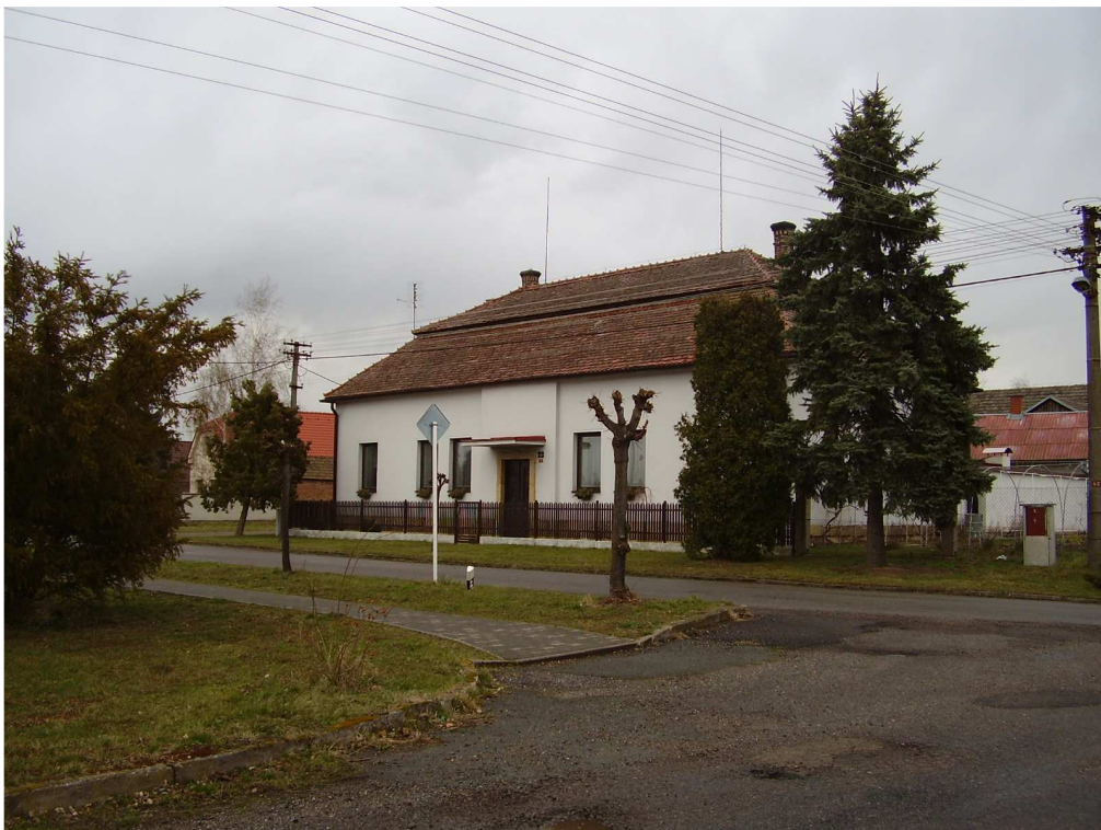
Obr. 4 - Budova mlékosrbské fary z roku 1908. Současný stav.
