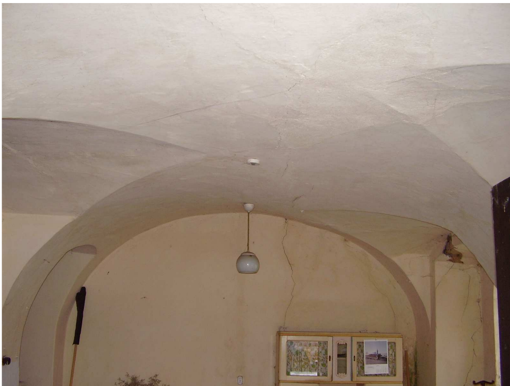
Obr. 65 - Valená klenba v sakristii s pětibokými výsečemi okenních otvorů a vstupního otvoru do presbytáře.
