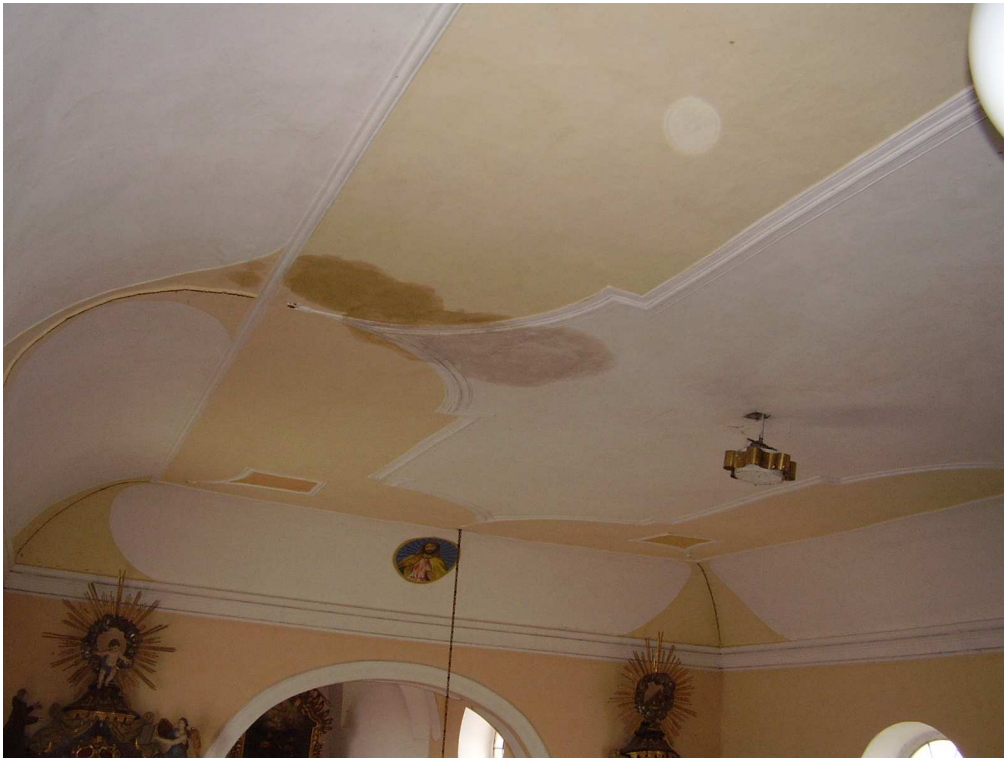
Obr. 60 - Podhledový strop s výrazným fabionem v lodi kostela.
