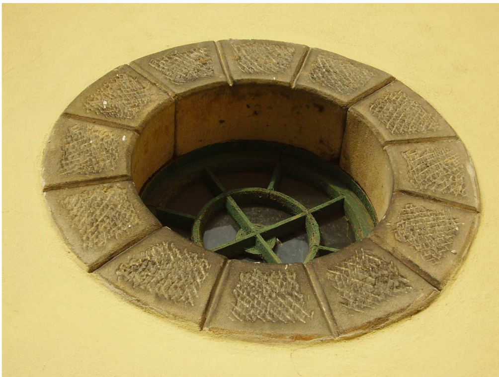
Obr. 51 - Detail vytesávaného iluzivního motivu obvodových klenáků. Kruhový okenní otvor v jižním věžním přístavku osvětluje prostor vřetenového schodiště.
