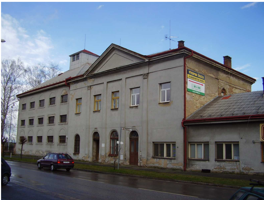
Obr. 19 - Bývalý hotel Liverpool z roku 1878 v Chlumci nad Cidlinou. Současný stav.
