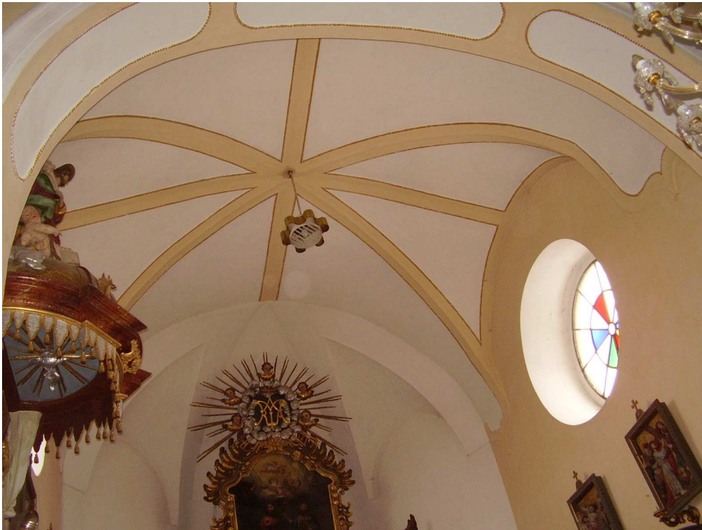
Obr. 64 - Kombinované klenutí polygonálně uzavřeného presbytáře.
