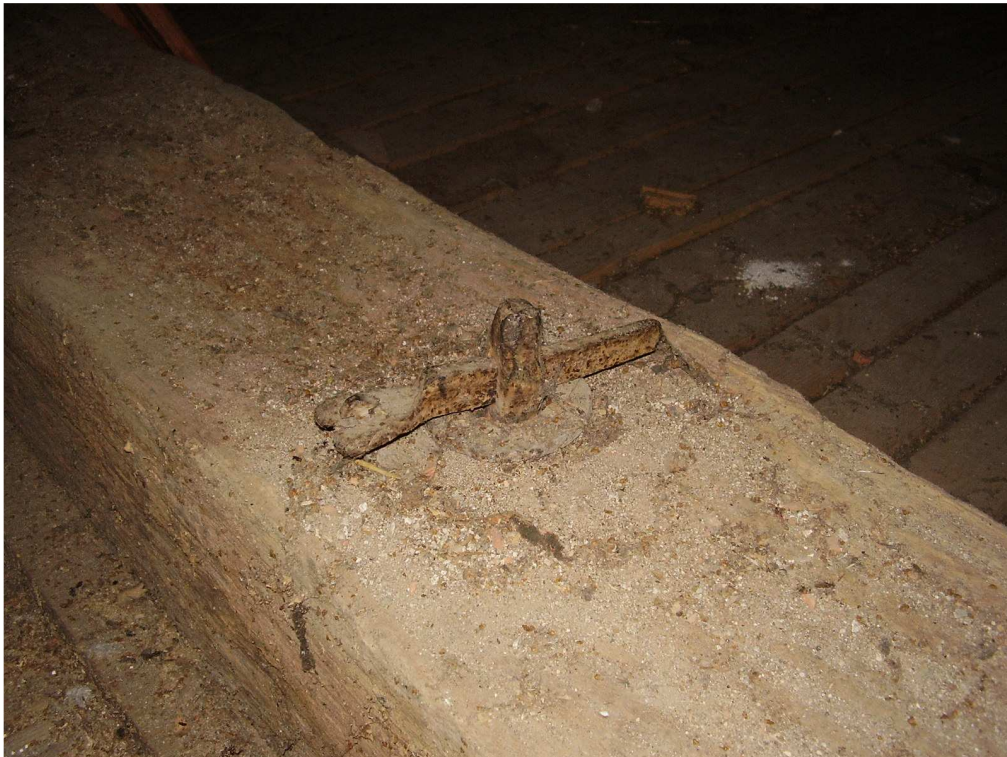
Obr. 75 - Kovaná klínová napínací zarážka v průvlakovém trámu.
