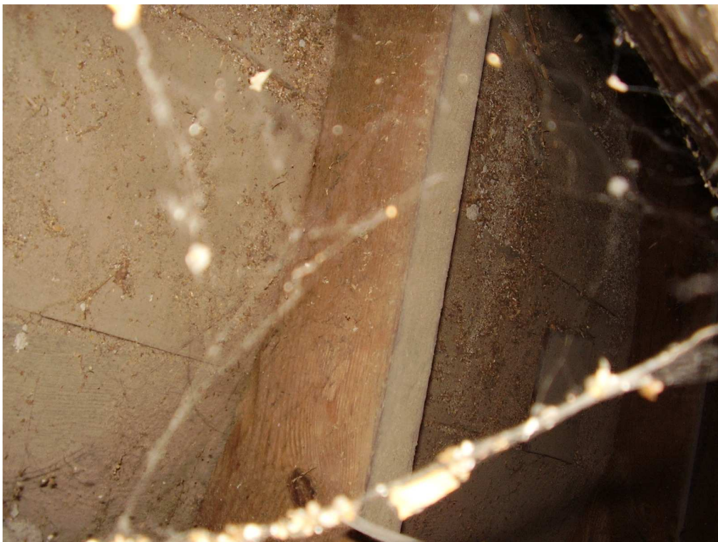
Obr. 77 - Pohled na prkenné bednění fabionu se segmentovými trámky.
