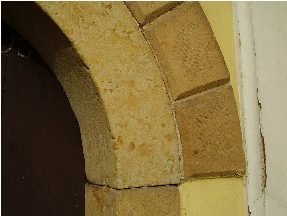
Obr. 50 - Detail pískovcových klenáků nad překladem vstupního portálu na tribunu.
