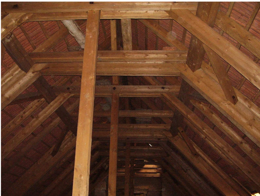
Obr. 83 - Pohled do krovu nad lodí kostela.
