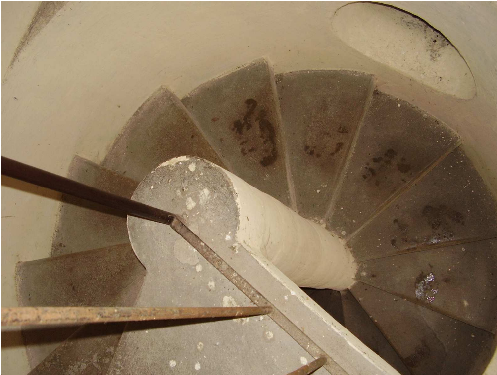
Obr. 66 - Levotočivé vřetenové schodiště.
