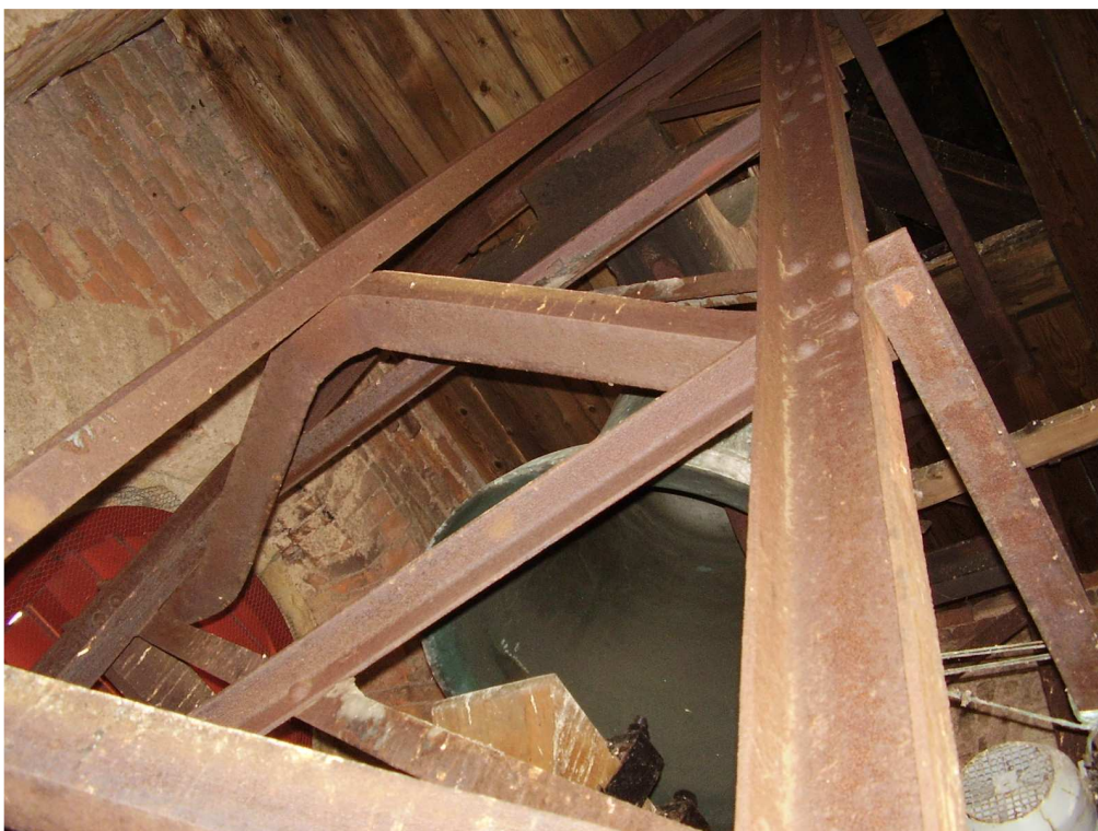
Obr. 69 - Pohled na zvonovou stolicí ve 4. patře modifikovanou pro zavěšení dvou zvonů.
