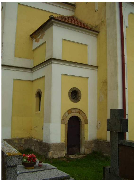
Obr. 49 - Vstupní portál na tribunu v jižním přístavku.
