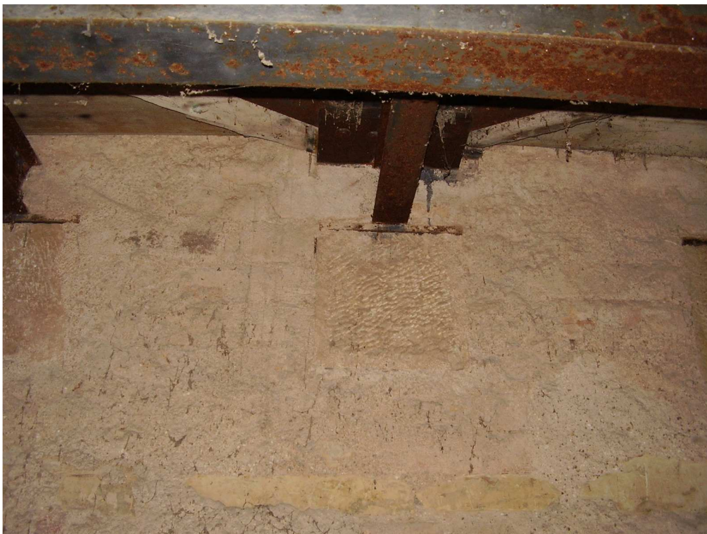
Obr. 61 - Podpěrné pískovcové kvádry zajišťující stabilitu ocelových zvonových stolic.
