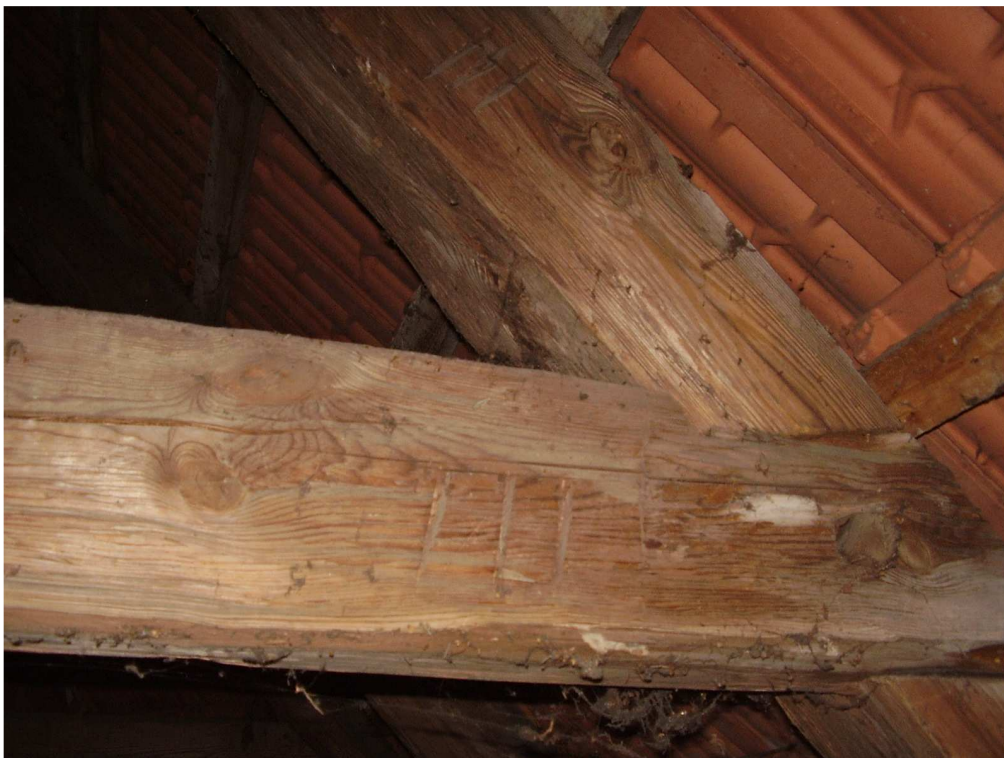
Obr. 79 - Tesařské značky ve krovu nad presbytářem.
