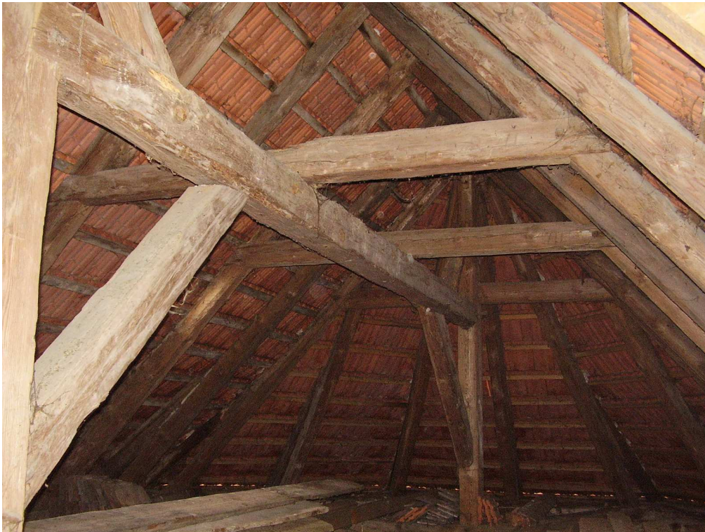
Obr. 78 - Pohled do krovu nad pětibokým presbytářem.
