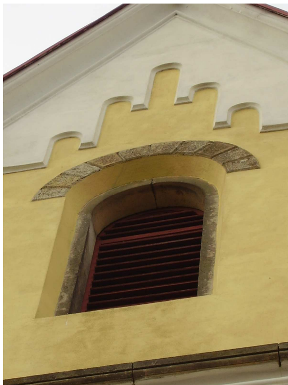
Obr. 56 - Zvonové okno ve čtvrtém patře věže.
