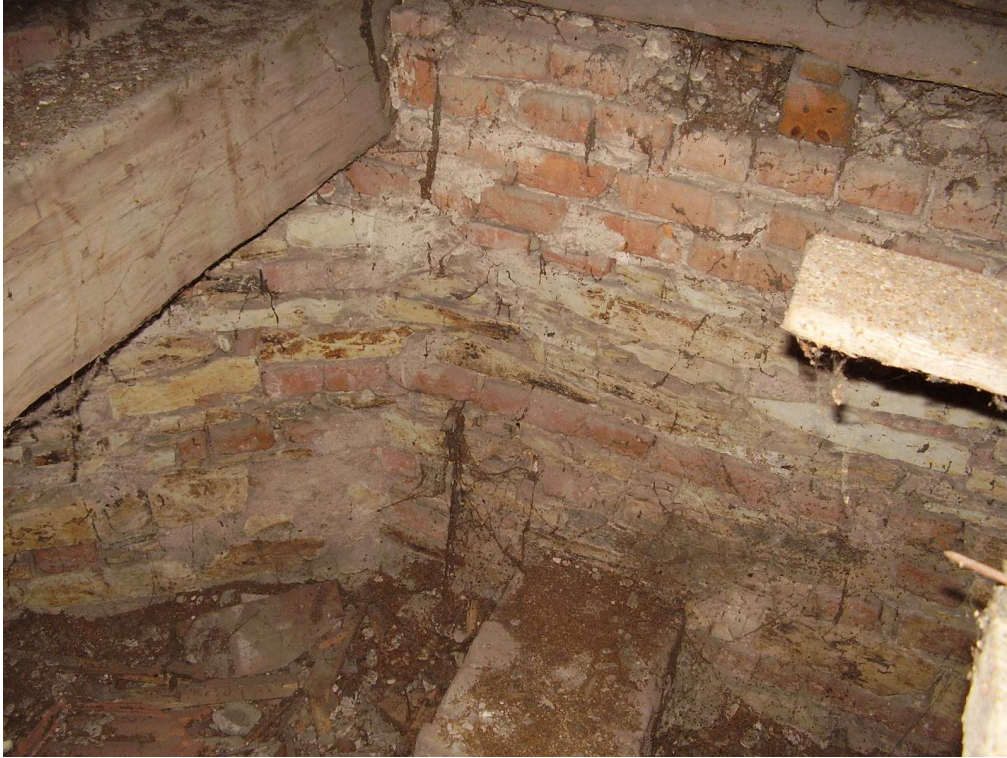
Obr. 82 - Kombinace cihel a opuky ve zdivu presbytáře.
