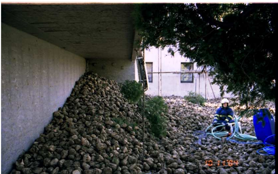
Obr. 6. Odčerpávání nafty od vodního zdroje, který je zasypán převážným nákladem
