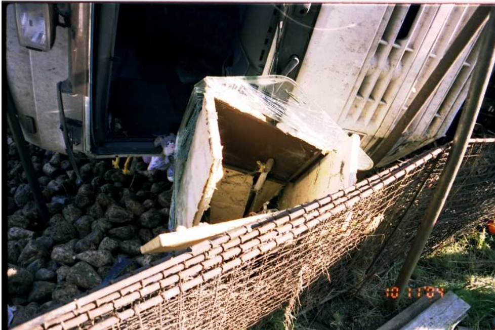
Obr. 3. Poškozený hlavní uzávěr plynu u rodinného domu
