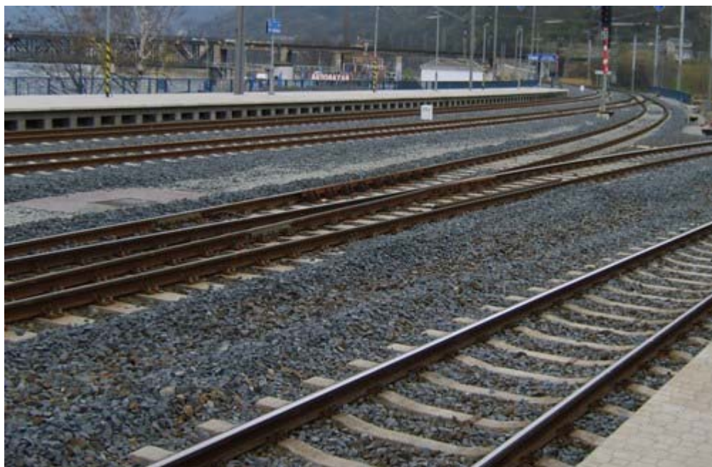
Obrázek č. 3: Výhybka č. 12 na 5 koleji
