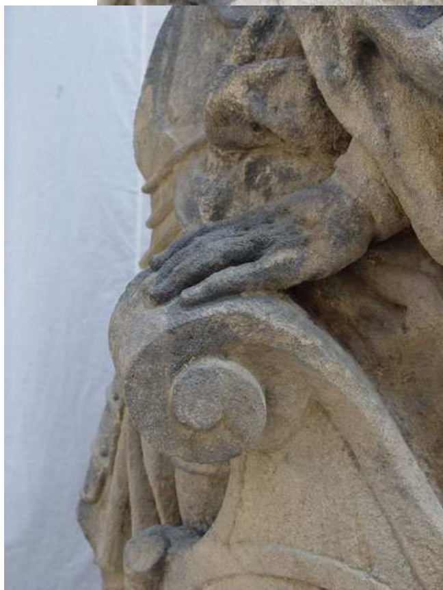
Obr. 49 stav před restaurováním - horní část štítu
