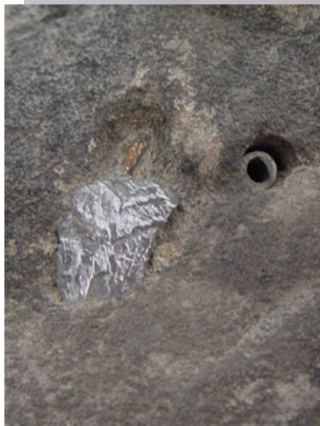
Obr. 36 olověný čep s mosazným drátem uvnitř nerezové trubičky
