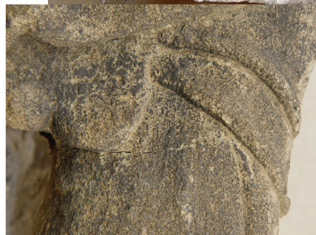
Obr. 26 stav před restaurováním - praskliny ve prasklina spodní části soklu
