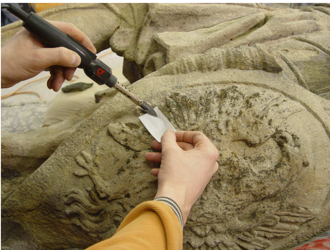
Obr. 16 průběh restaurování - zajištění vrstev povrchové úpravy pomocí injektáže
