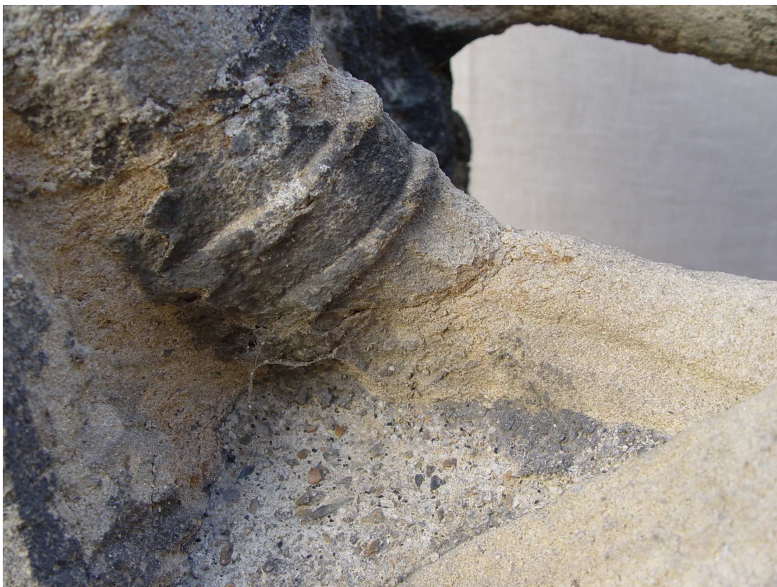
Obr. 20 stav před restaurováním - detail sádrovcové krusty na levém chodidle
