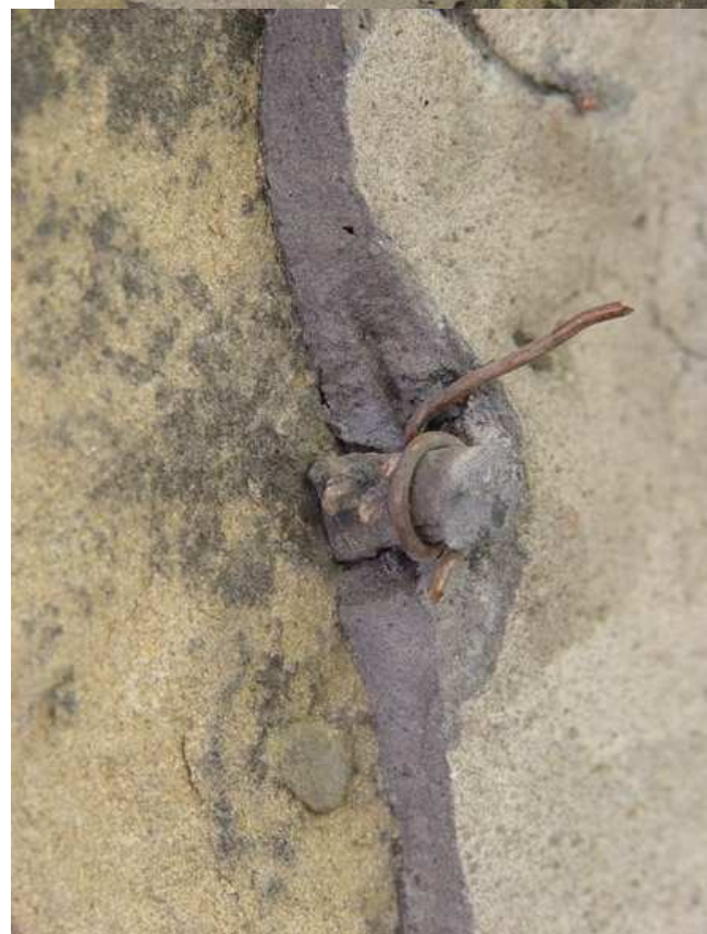
Obr. 34 stav před restaurováním - tmel na zadní straně sochy s olověnými čepy
