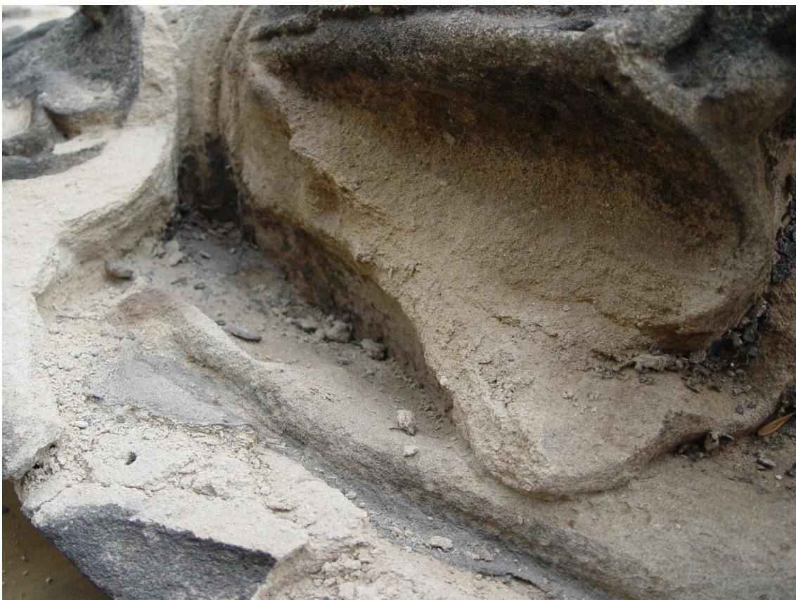
Obr. 12 stav před restaurováním - detail koroze kamene v levé části pláště
