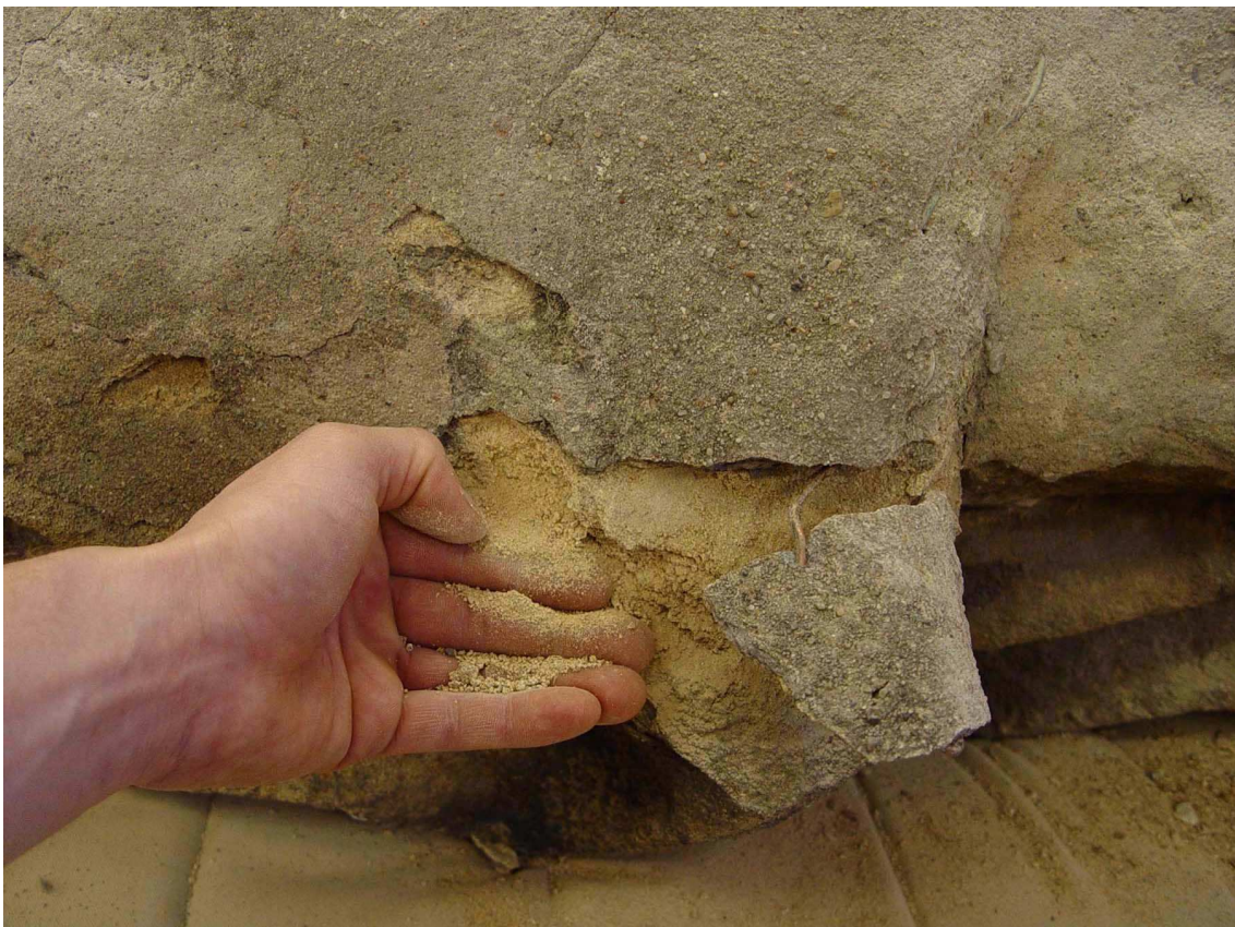
Obr. 10 stav před restaurováním - korodovaný kámen pod tmelem na zadní straně sochy
