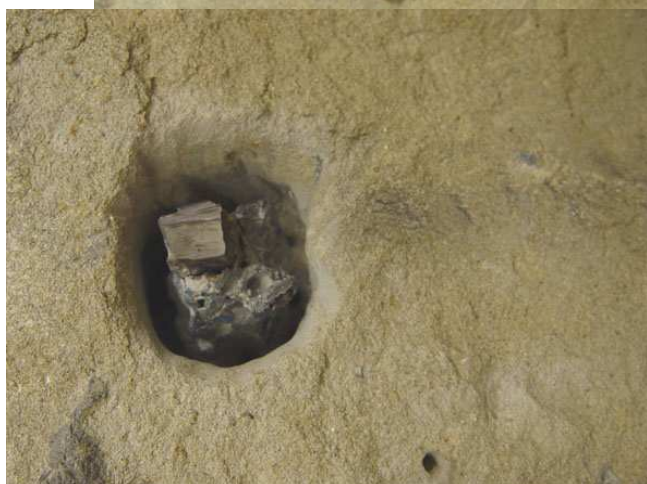
Obr. 24 průběh restaurování - zadní část sochy, uřezání kotvící železná tyč před uřezáním
