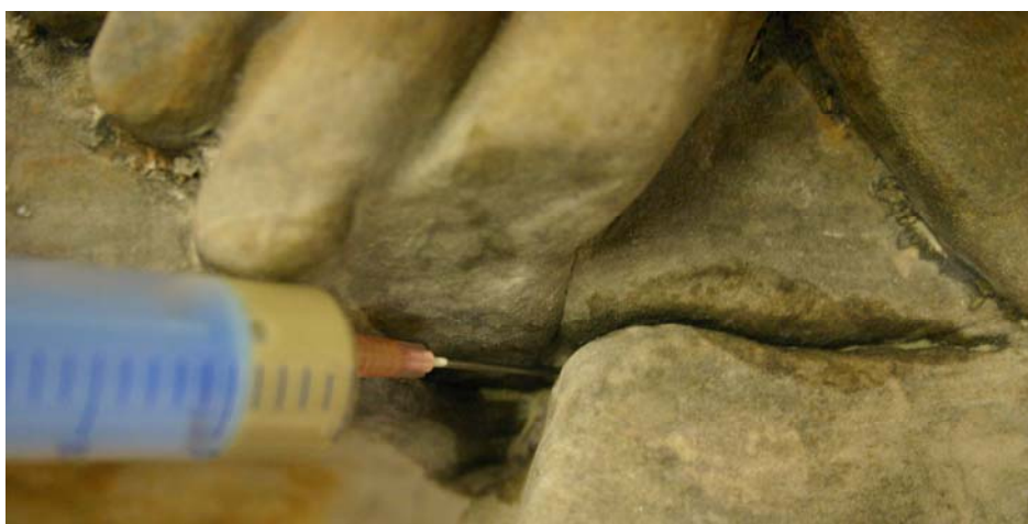
Obr. 27 Lokální zpevnění kamene organokřemičitým prostředkem Funcosil KSE 300
