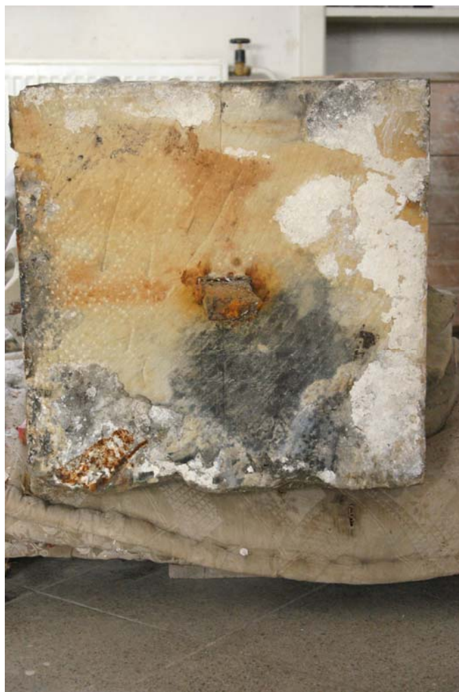
Obr. 6 Korodující dvojitý železný čep zalitý olovem v základně.
