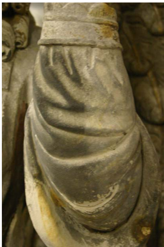
Obr. 33 Dočištění tmavých míst pomocí mikroabrazivní metody, vpravo očištěný povrch
