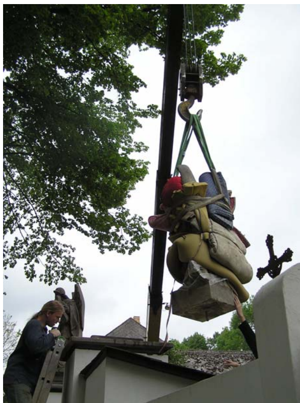
Obr. 71 Osazování sochy na vápeno – cementovou maltu. Socha je kotvena nerezovým čepem vlepeným do základny.
