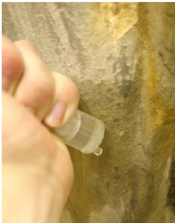
Obr. 21, Obr. 22 Předzpevnění narušených míst před čištěním nízkotlakou vodní párou.
