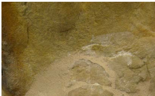
Obr. 31 Zajištění částečně odtržené části spodního levého rohu plyntu. Injektáž nízkoviskózní epoxidovou pryskyřicí před vsazením nerezové armatury.
