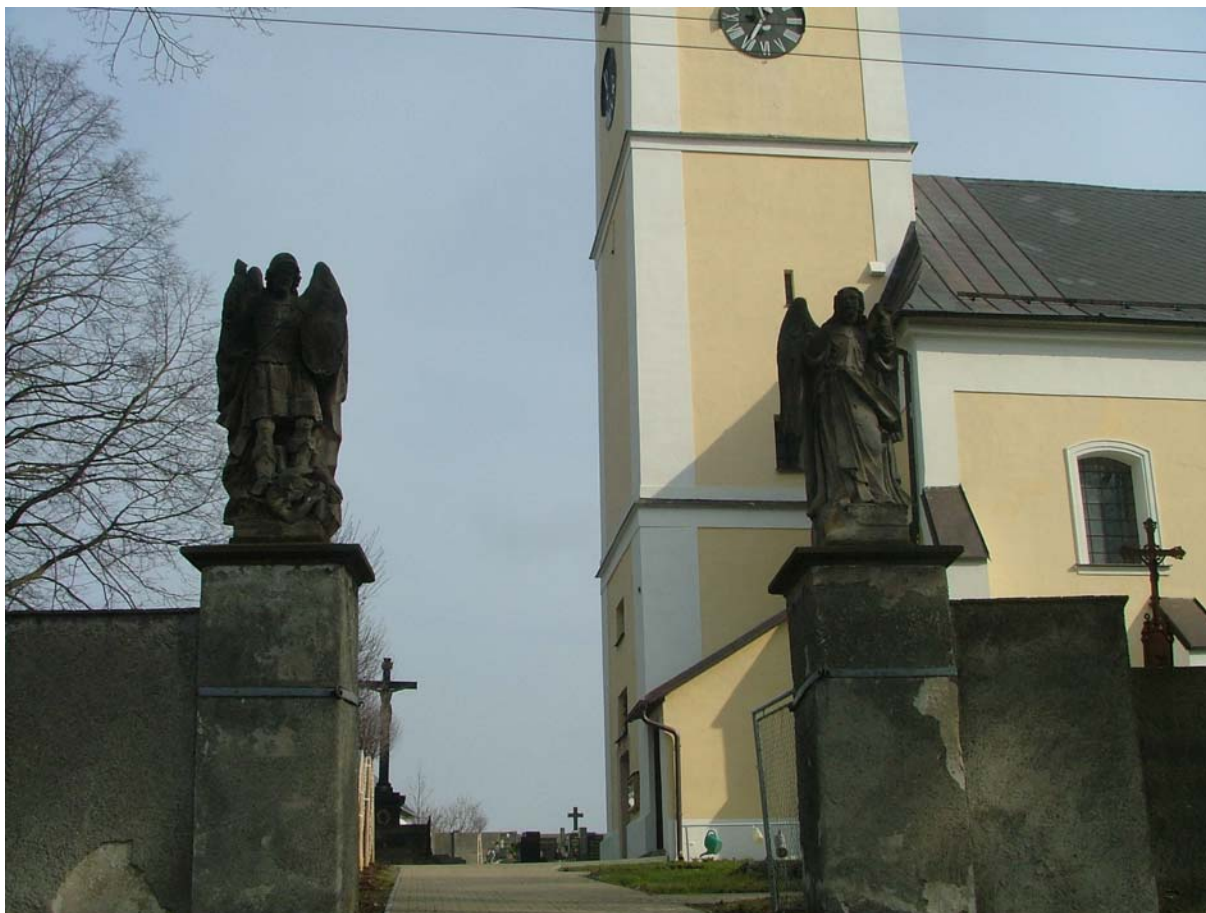
Obr. 1 Dvojice andělů na vstupní bráně farního hřbitova v Pomezí u Poličky. Vpravo Anděl posledního soudu. Stav před transportem do atelieru Fakulty restaurování.
