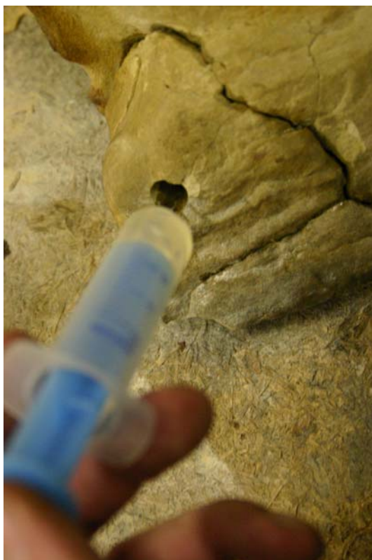
Obr. 31 Zajištění částečně odtržené části spodního levého rohu plyntu. Injektáž nízkoviskózní epoxidovou pryskyřicí před vsazením nerezové armatury.
