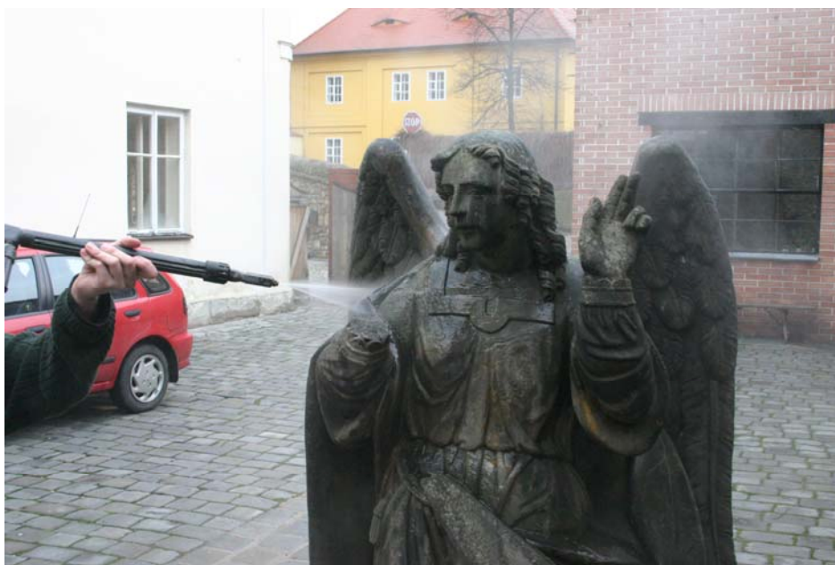
Obr. 25 Průběh čištění nízkotlakou regulovatelnou vodní párou
