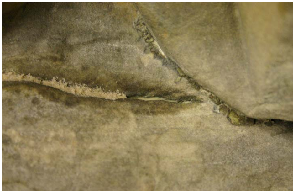
Obr. 29 Prasklina vyplněná injektáží směsí Funcosilu KSE 500 E s plnivem Füllstof A
