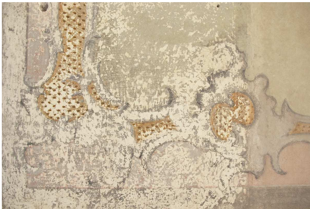
Obr. 26 Stav po očištění, odstranění přemaleb
