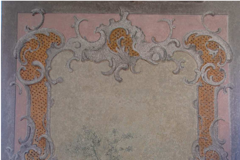
Obr. 10 Stav před restaurováním
