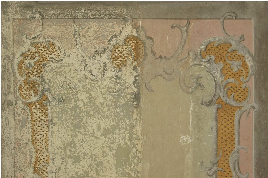
Obr. 24 Stav po očištění, odstranění přemaleb, vytmelení
