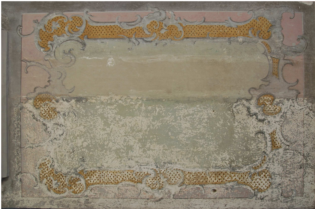
Obr. 29 Stav po očištění, odstranění přemaleb, vytmelení
