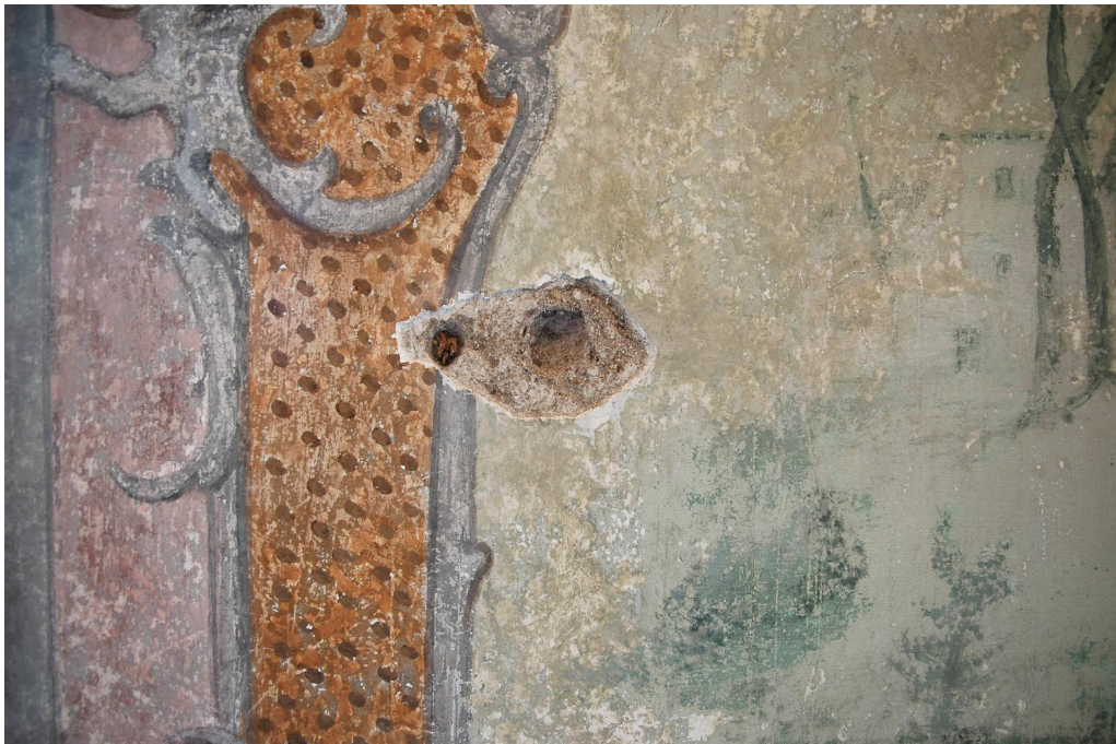
Obr. 7 Po odstranění druhotné sádrové vysprávky
