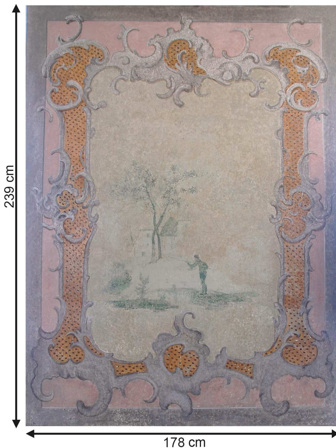
Obr. 5 Díl č. 1 (stav před restaurováním)
