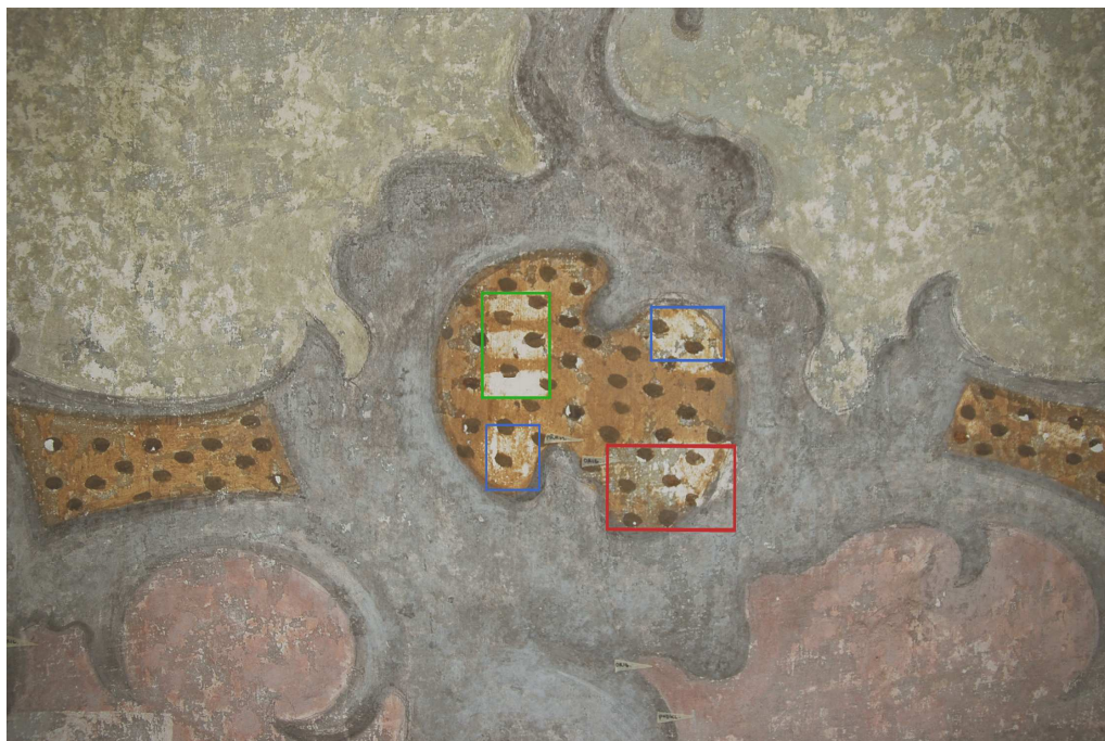
Obr. 23 Destruktivní průzkum - zkouška čištění
