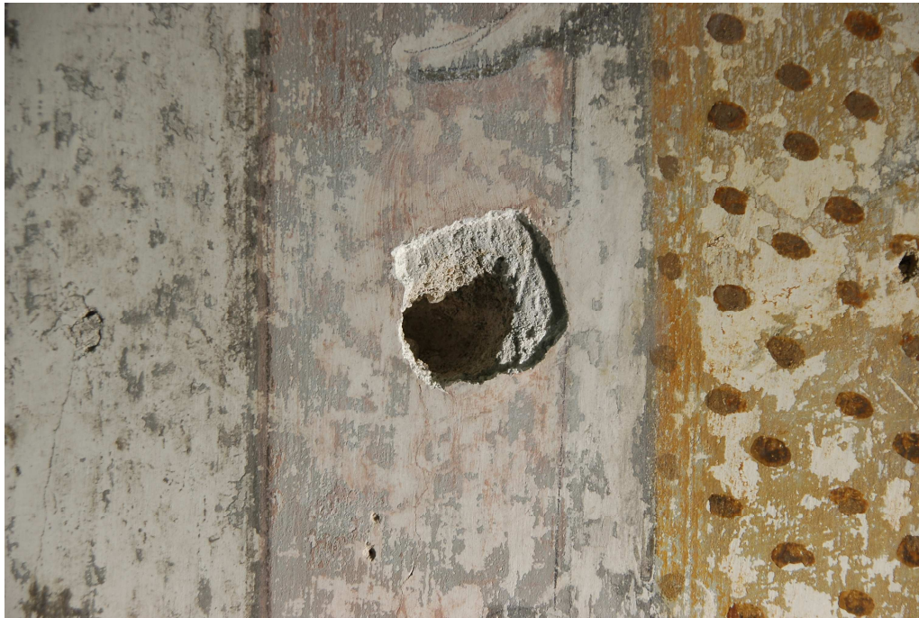
Obr. 20 Po odstranění druhotné sádrové vysprávky
