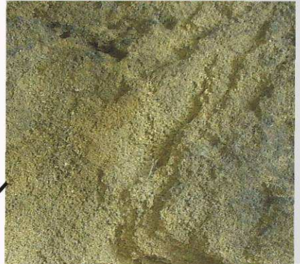
Mechanické poškození vlivem korodující železné konstrukce
