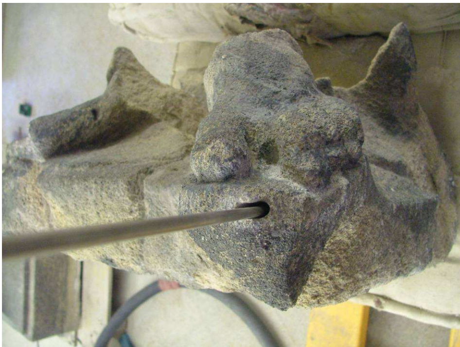
Obr.25. Nejsvětější Salvátor , aplikace armatury do plintu pod levou nohou
