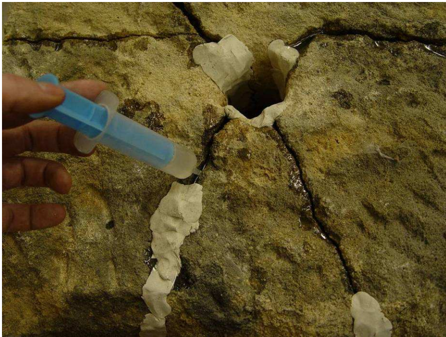
Obr.24. Nejsvětější Salvátor , konsolidace podstavné plochy epoxidem
