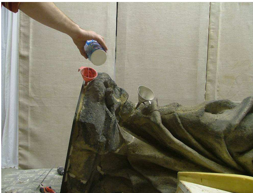
Obr.29. Nejsvětější Salvátor , Konsolidace vnitřních poškození epoxidem
