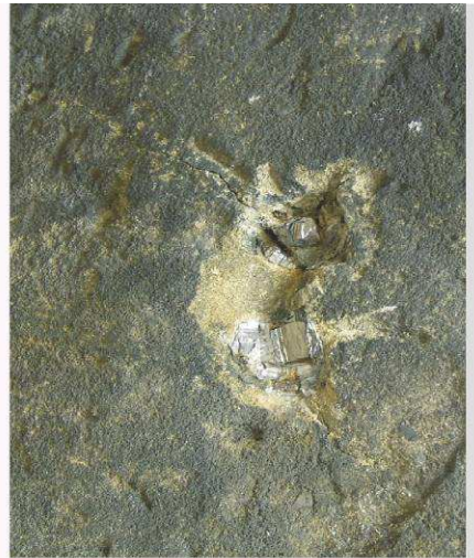
Mechanické poškození vlivem korodující železné konstrukce
