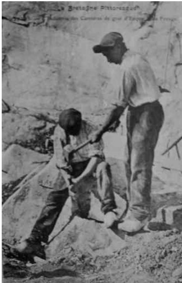
Obr. XII. Vrtání, fotografie z počátku 20.stol.. Vrtání lomařským vrtákem
