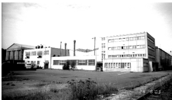
Obrázek 5 - Bývalá elektrárna Poříčí
