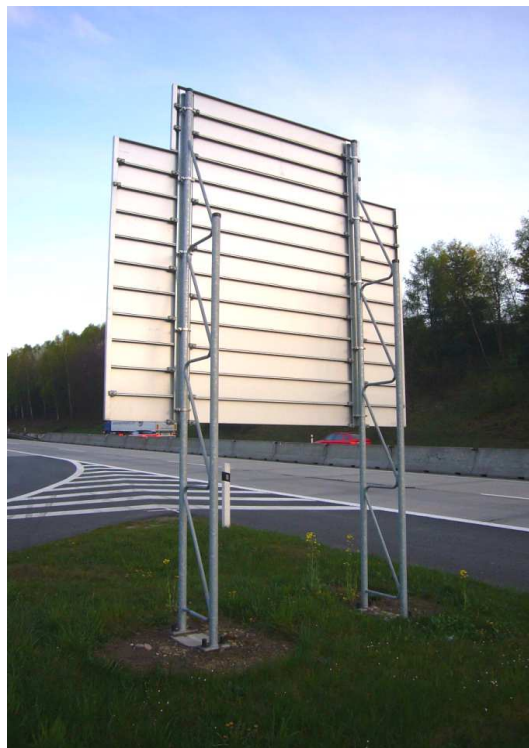
Obrázek č. 13 Příhradová konstrukce
