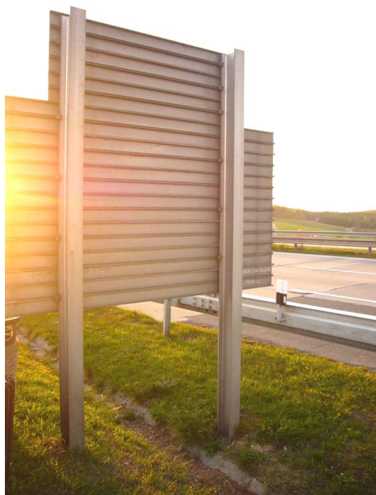
Obrázek č. 12 Konstrukce z I profilů
