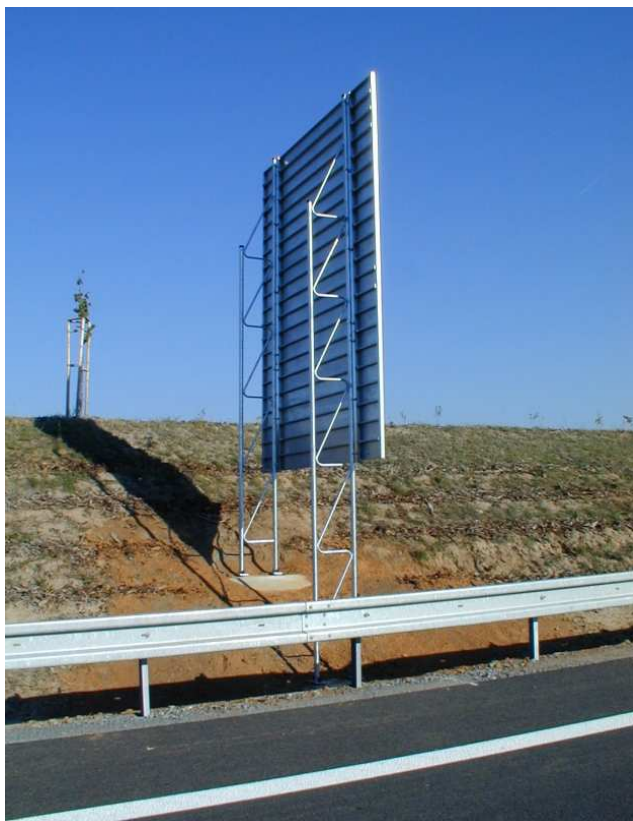
Obrázek č. 5 Příhradová konstrukce značek
