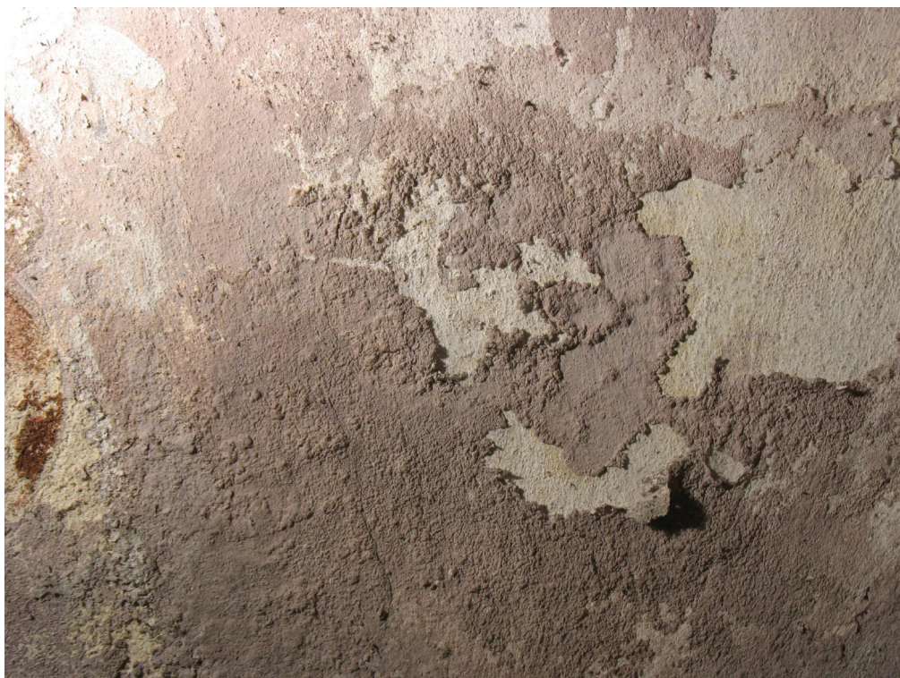
Obr. 19 Zpuchýřkovatění barevné vrstvy způsobené vlivem solí.
