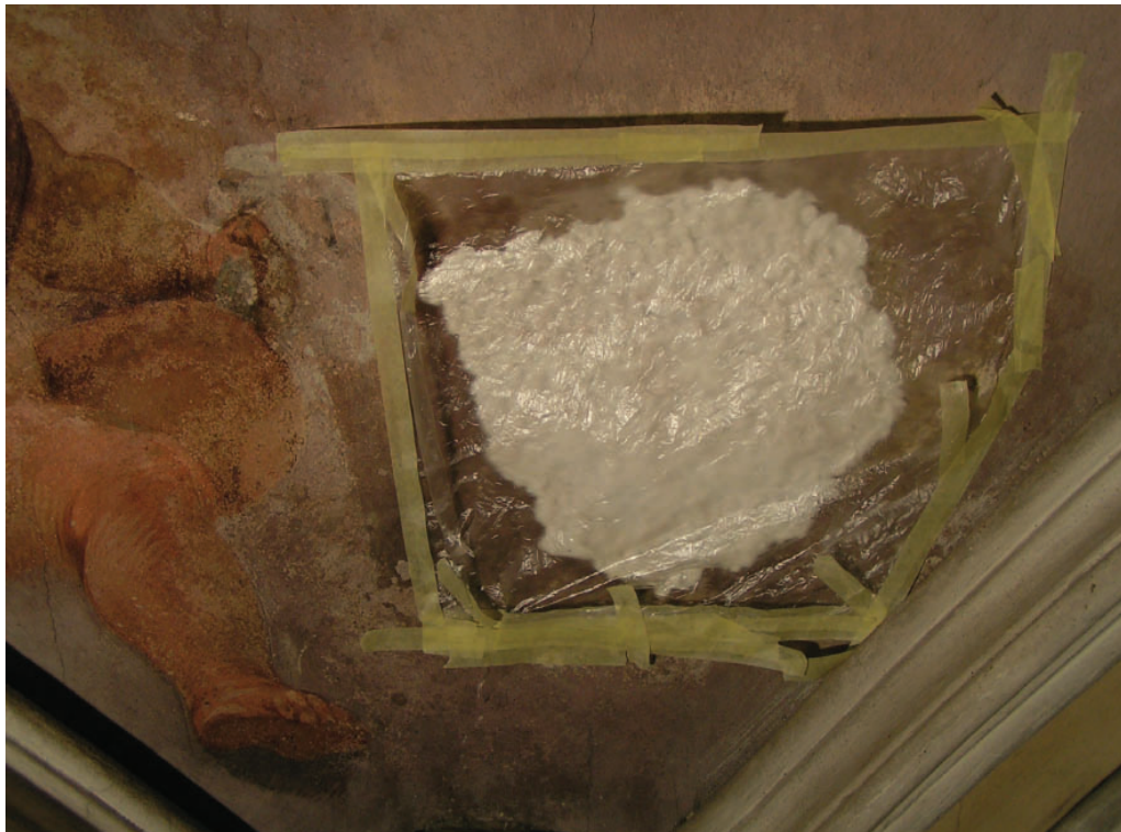
Obr. 45 Stabilizace solí pomocí obkladu \text{Ba}(\text{OH})_2
