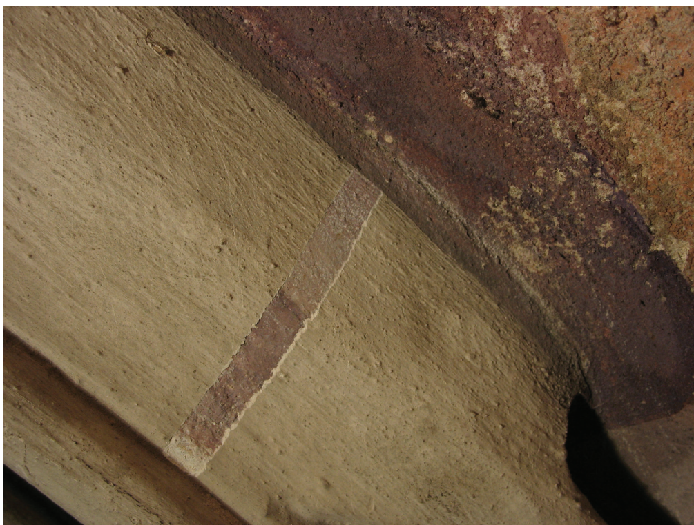
Obr. 27 Sonda na štuku.
