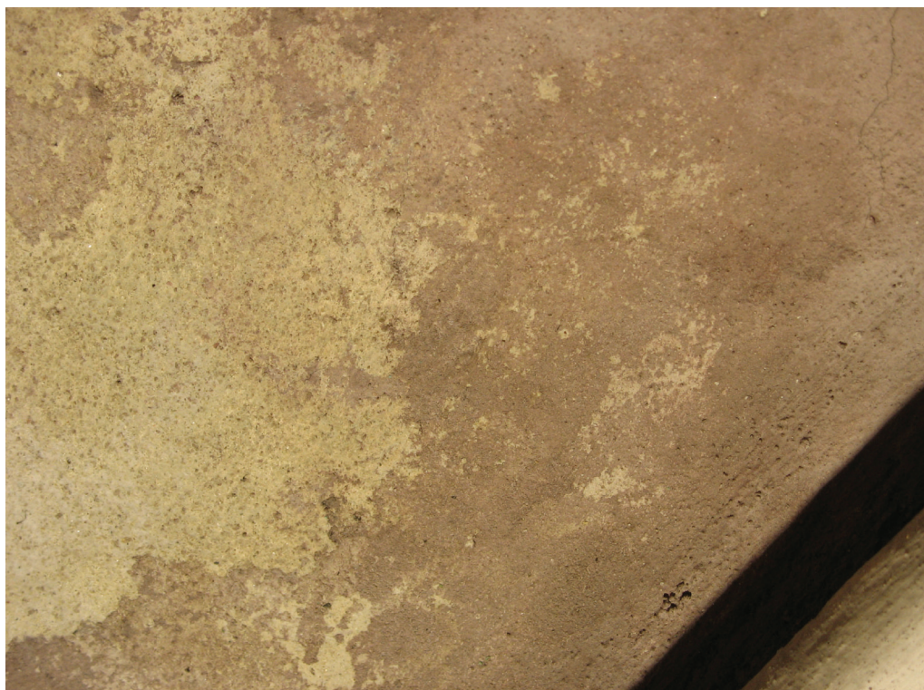
Obr. 43 Stav před obkladem
