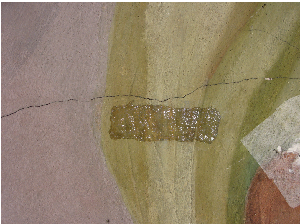
Obr. 33 Aplikace iontoměniče C100 EHLT na přemalbu; v tomto případě byl originál po odstranění přemalby ve velmi fragmentálním stavu, tudíž bylo rozhodnuto přemalbu zachovat.
