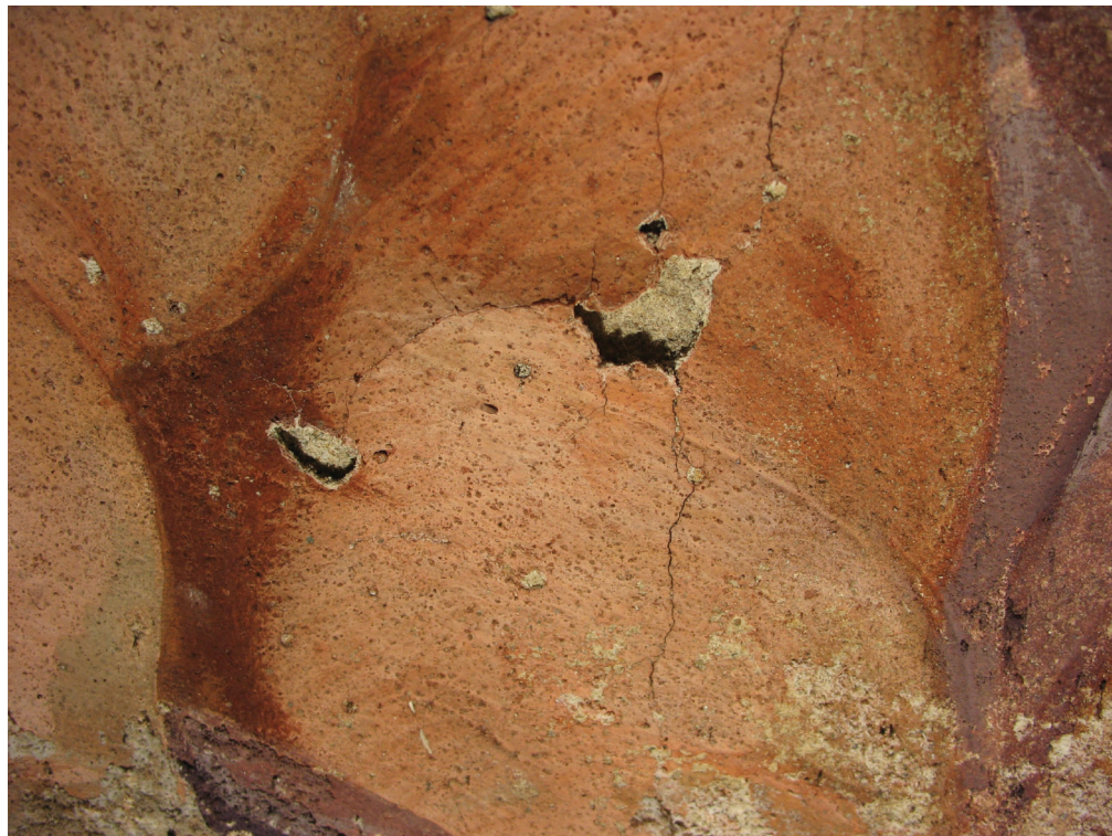
Obr. 20 Puchýře oddělující se od intonaca.
