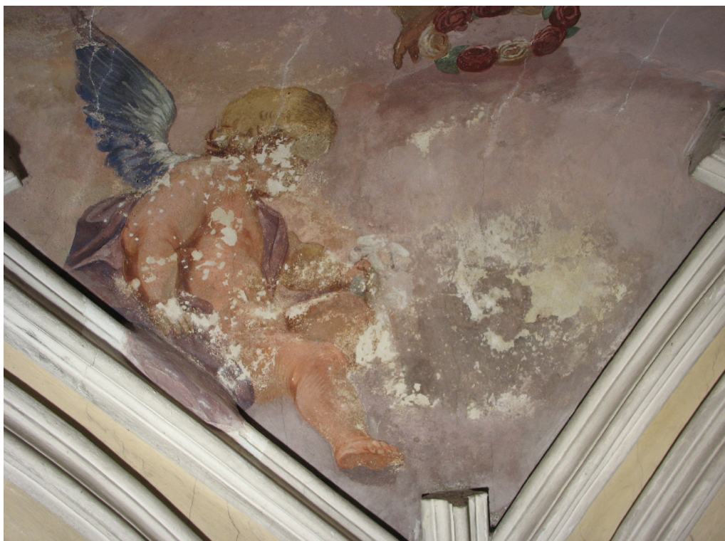
Obr. 50 Stav anděla “sedícího” na štuky po tmelení
