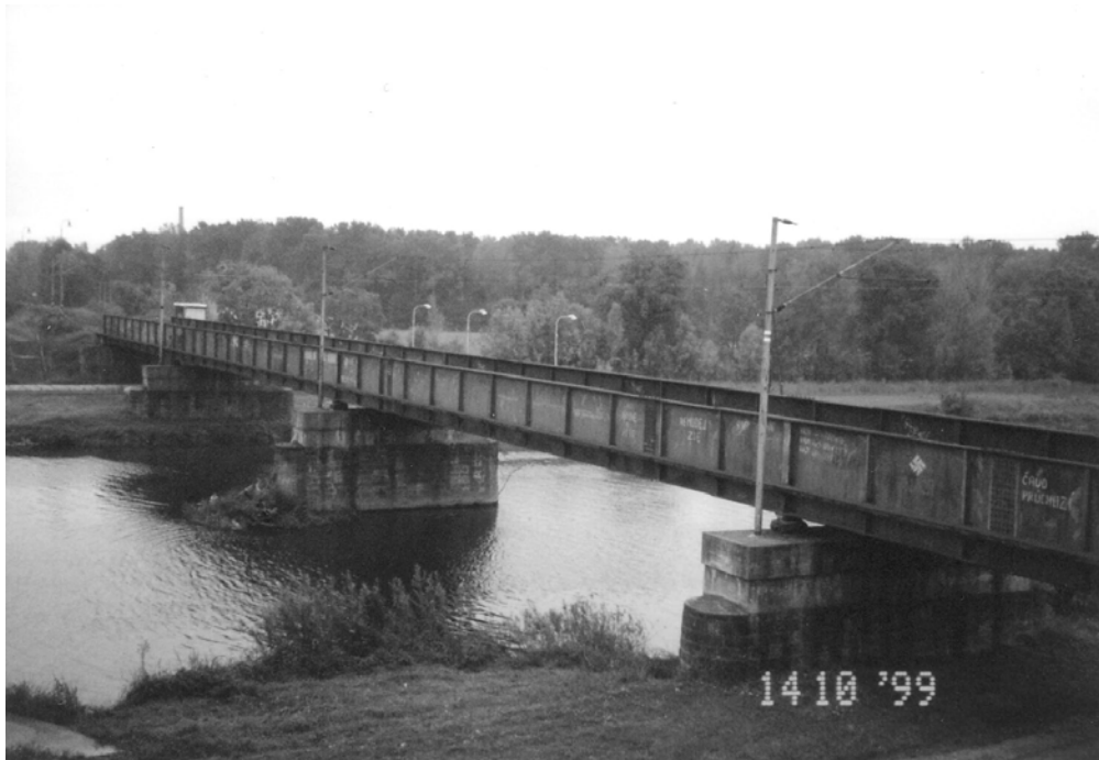
Obr.7.2. Mostní ocelová konstrukce (pohled č.2)
