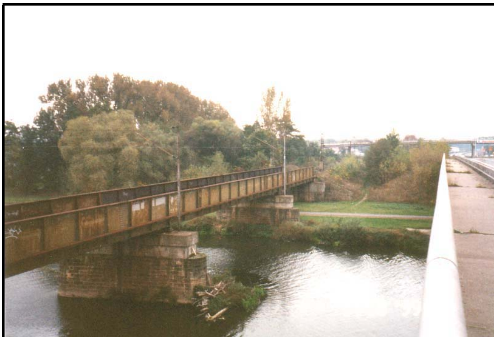
Obr. 7.1. Mostní ocelová konstrukce (pohled č.1)
