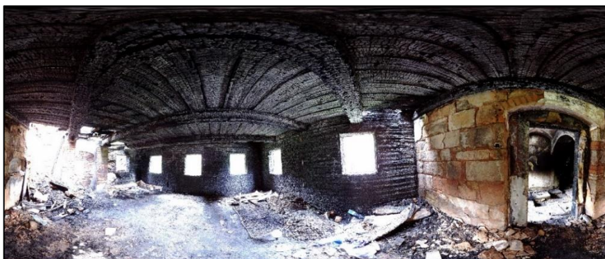
Obrázek 96 - Sférický snímek místnosti roubenky pořizený skenerem FARO X150 (Zdroj: vlastní)
