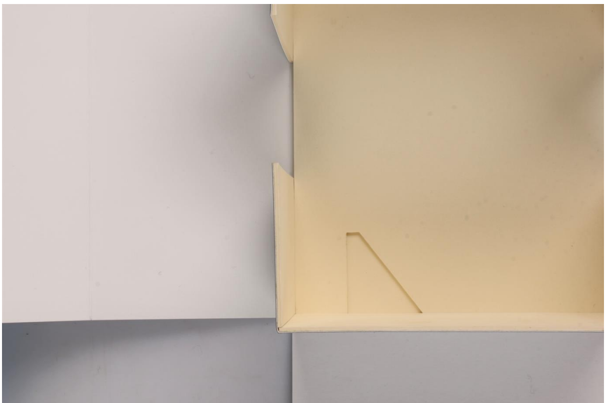
Obrázek 113 Pohled na výřez pro nárožnici knihy ve dně ochranné krabice
