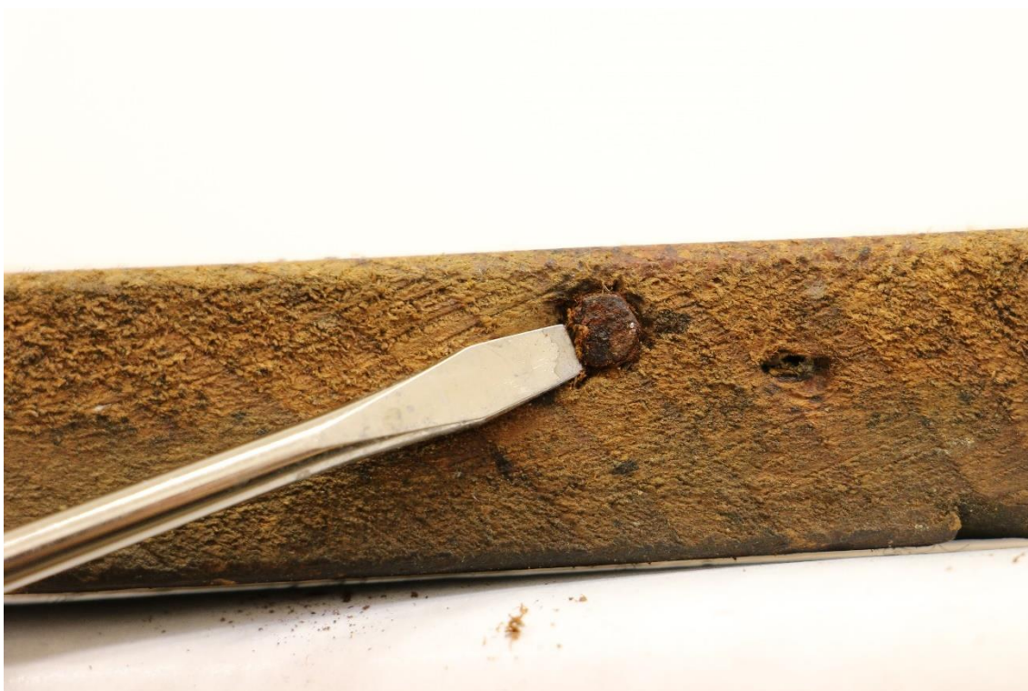
Obr. 45, Odstraňování zkorodovaných hřebíků z originálního dřevěného rámu
