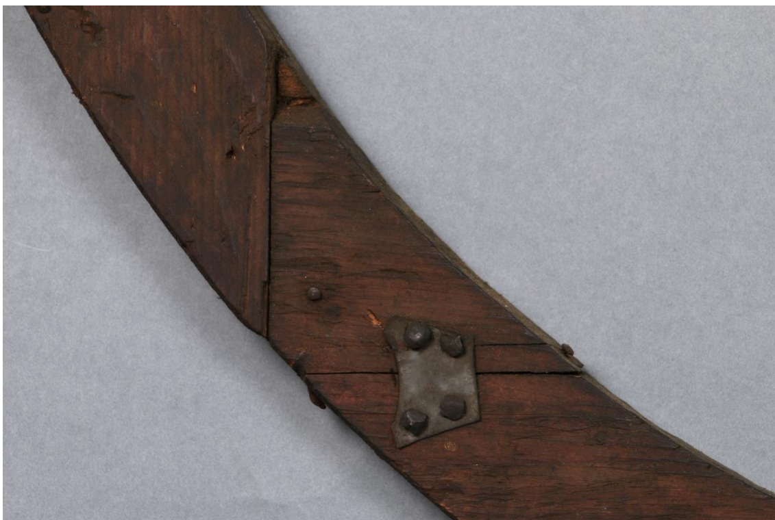
Obr. 42, Stav před restaurováním, dřevěný originální napínací rám, detail kovové armaturky vlevo
