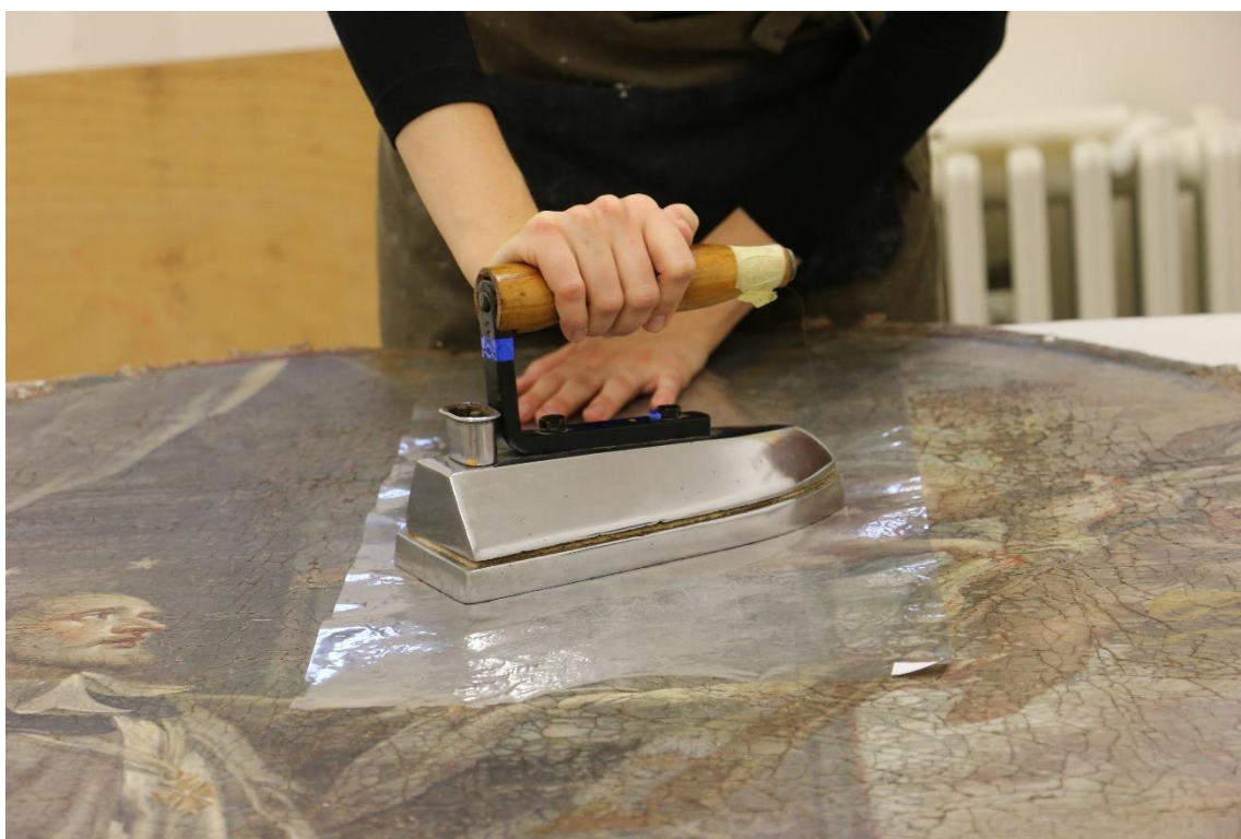
Obr. 18 Průběh restaurování, zažehlování konsolidačního roztoku BEVA 375 přes antiadhesivní fólii Hostaphan
