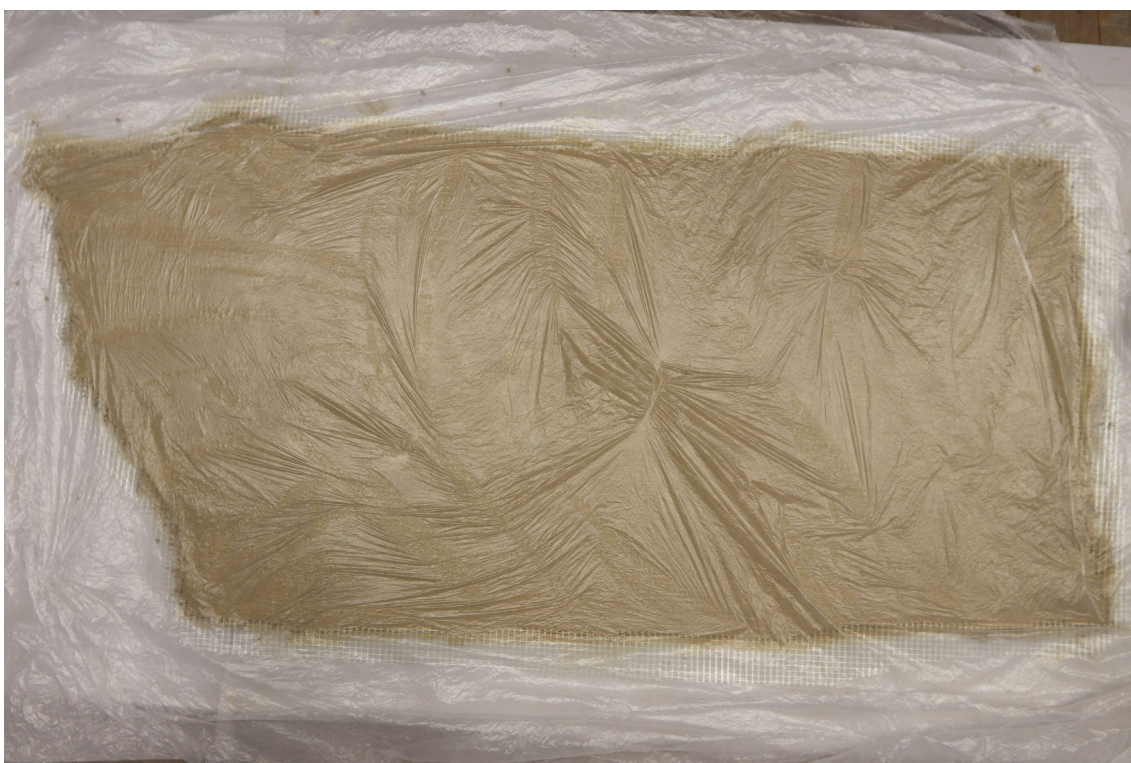
Obr. 137: Postup restaurátorských prací: nanášení omítkové vrstvy a sklovláknité armovací mřížky na rub jednoho z transferových dílů.
