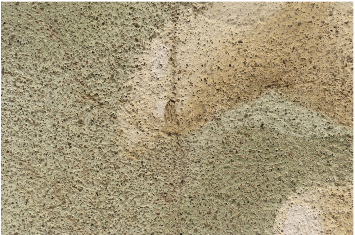
Obr. 117: Detail zachycuje provedení původní malby na hrubý povrch omítky a spáru vzniklou mezi jednotlivými díly malby při snímání. Spoj dílů 1K a 2K. Stav po osazení na panel a sejmutí přeplepu.
