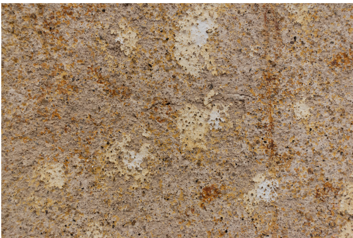
Obr. 121: Detail zachycuje pravděpodobně větší kámen v omítce, jenž je součástí původní realizace. Díl 1K. Stav po osazení na panel a sejmutí přeplepu.
