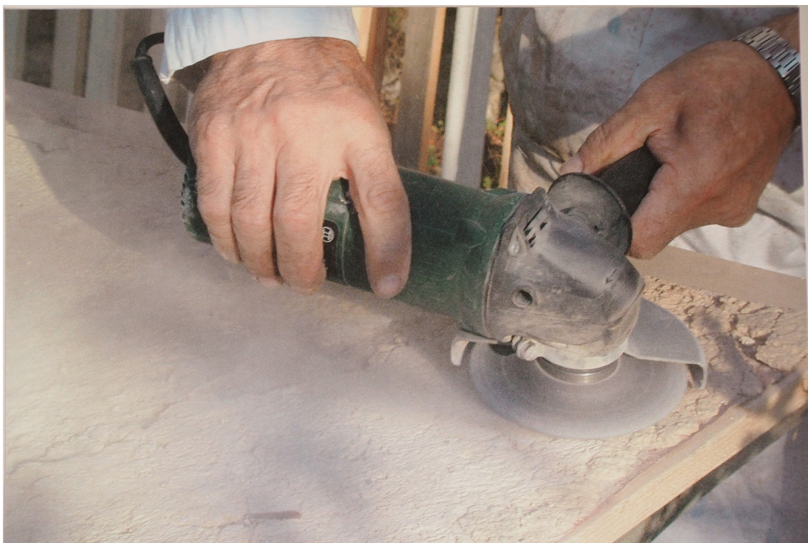
Obr. 51: Detail rubové strany transferu, stav před zeslabením omítkové vrstvy. Archiv NPÚ Locket., součást restaurátorské zprávy z roku 2001
