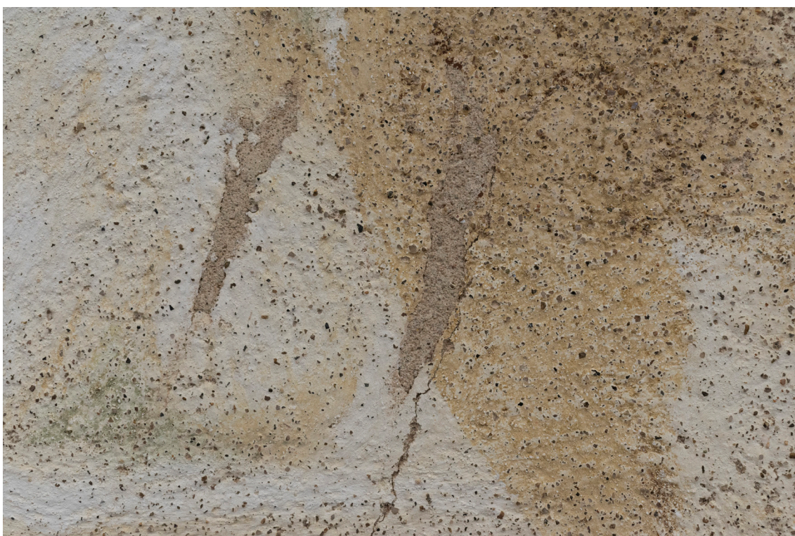
Obr. 155: Postup restaurátorských prací: konsolidace originální barevné vrstvy vápennou nanosuspenzí CaLoSiL® E25.
