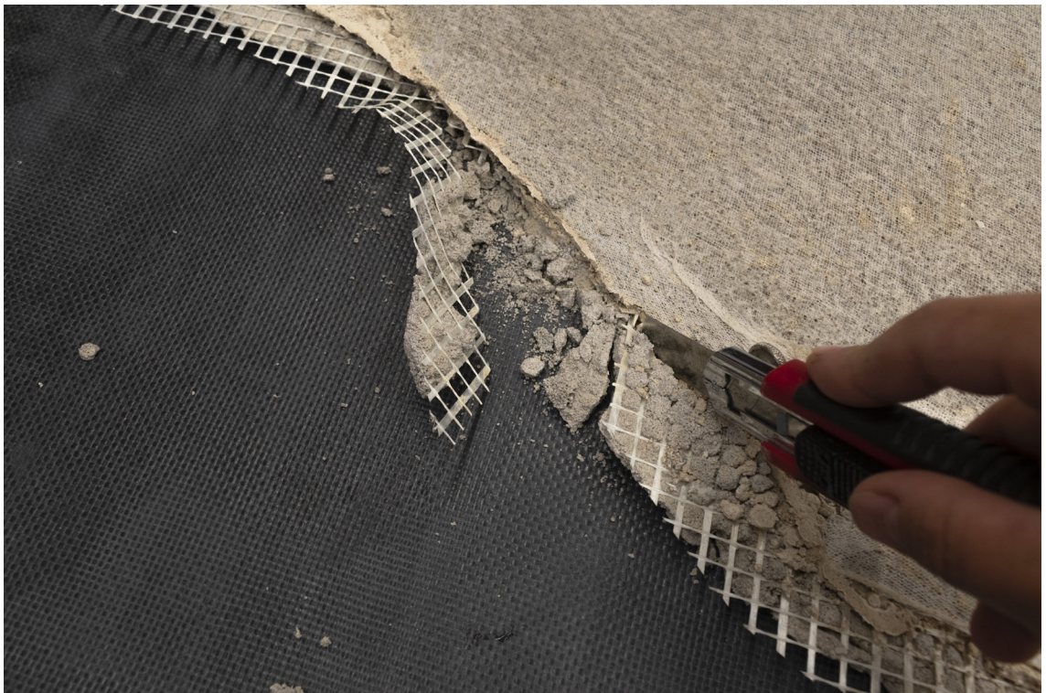
Obr. 149: Postup restaurátorských prací: stav po odstranění přelepové gázy.
