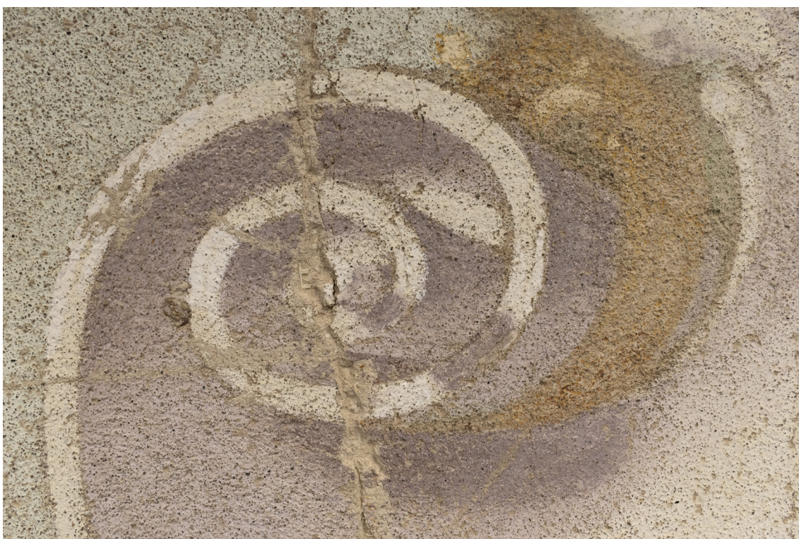
Obr. 119: Detail zobrazující poškození malby prasklinami. Stav po osazení na panel, sejmutí přeplepu a očištění.
