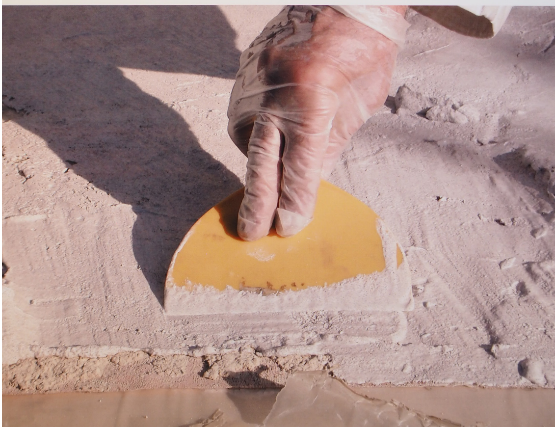
Obr. 53: Rubová strana transferu, nanášení zpevňující omítkové vrstvy. Archiv NPÚ Locket., součást restaurátorské zprávy z roku 2001.
