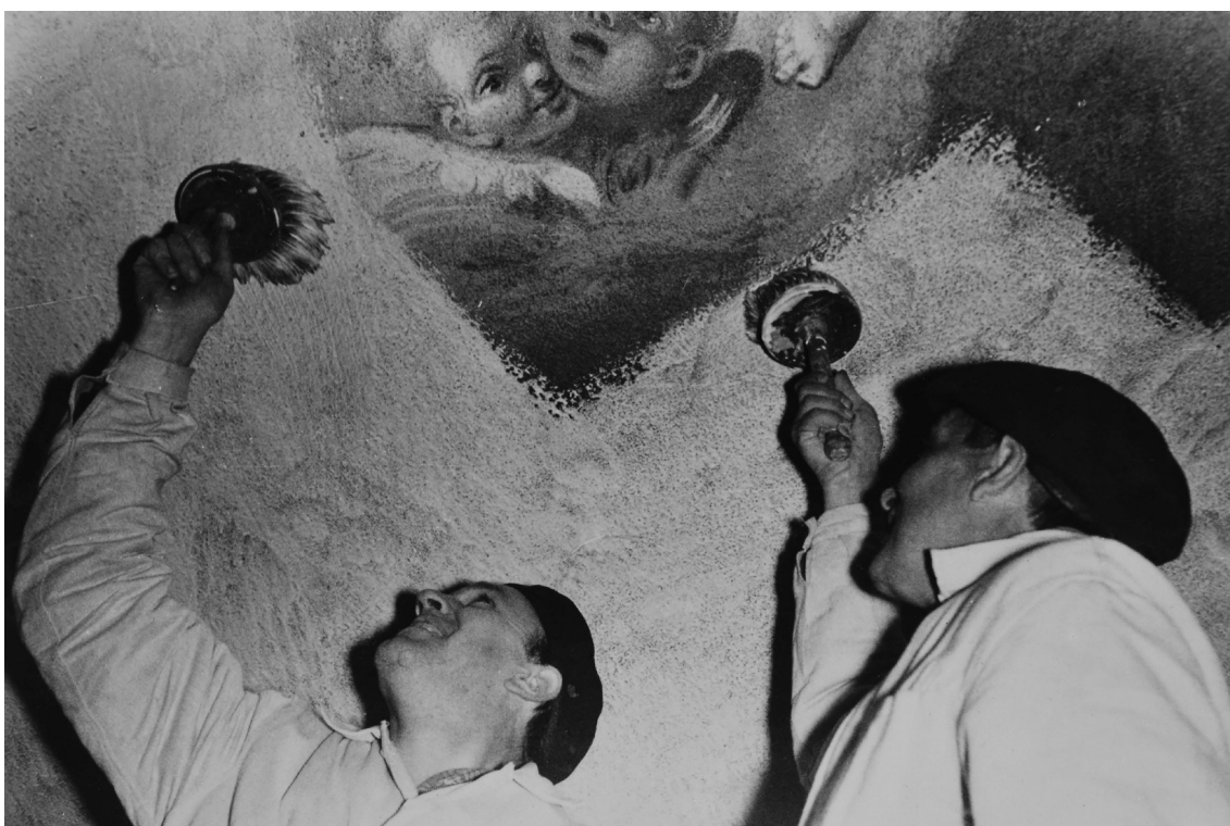
Obr. 24: Historická fotografie zachycjící průběh restaurátorských prací na lešení. Zdroj: pozůstalost po Vlastimilovi Bergerovi.
