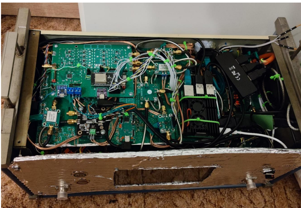
Obrázek 8.4: Náhled na smontovanou bednu se všemi bloky. (Zdroj: Vlastní.)
