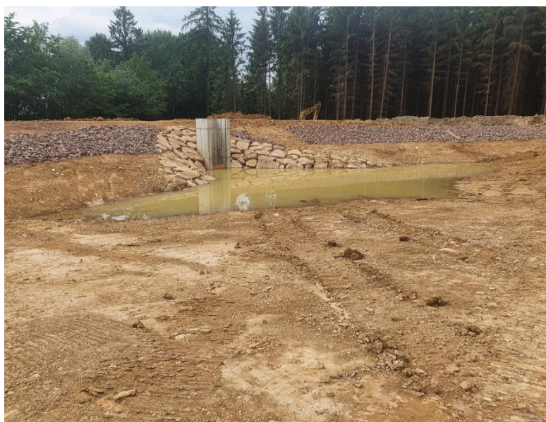
Obrázek 5: Probíhající stavba dočišťovacího rybníčku
