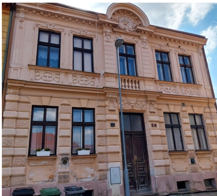
Obr. č. 19 Dům č.p. 26/24, Na Kozinci (foto autor)
