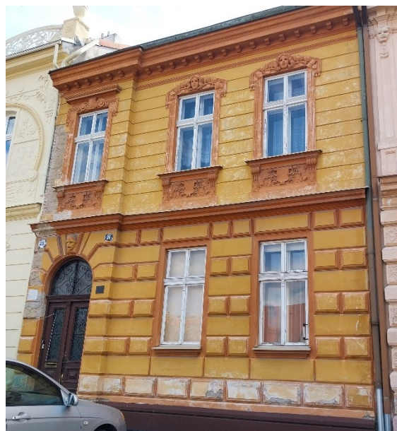
Obr. č. 18 Dům č.p.25/26, Na Kozinci (foto autor)
