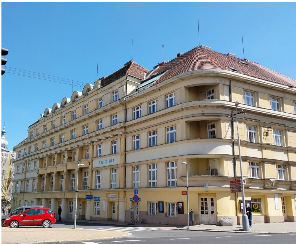
Obr. č. 26 Bývalá budova okresní nemocenské pojišťovny, dnešní Poliklinika (foto autor)
