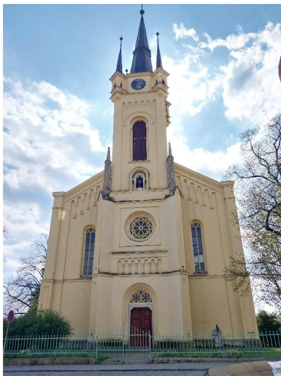
Obr. č. 4 Evangelický kostel (foto autor)
