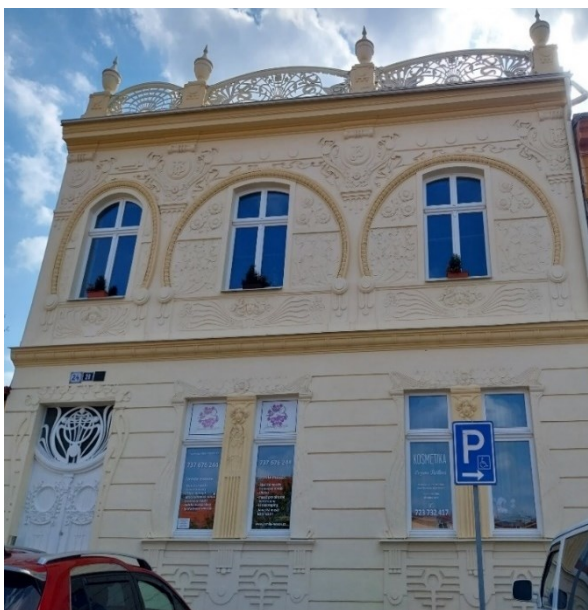
Obr. č. 17 Dům č.p. 24/28, Na Kozinci (foto autor)
