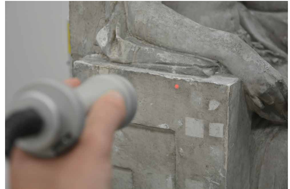
8.2.6. Průběh čištění pomocí SFR laseru EOS 1000. Při čištění laserem hraje zásadní roli zkušenost a citlivost operátora. Na příklad kroužením hlavičky spouště se správně zaostřeným bodem dosáhneme rovnoměrnějšího čištění. (foto: J. Škarvada)
