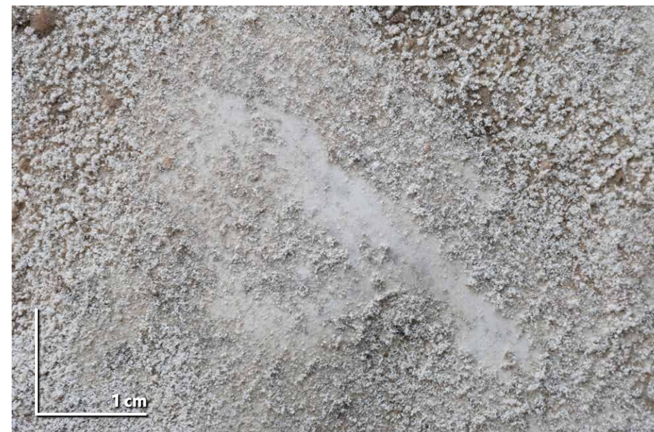
5.5. Výkvěty sádrového pojiva na povrchu odlitku dlouhodobě skladovaného v prostředí s relativní vzdušnou vlhkostí 93–100 %. (foto: P. Zítková)
