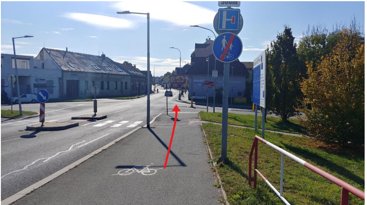
Obrázek 12 Chybné napojení cyklostezky na silnici II/333
