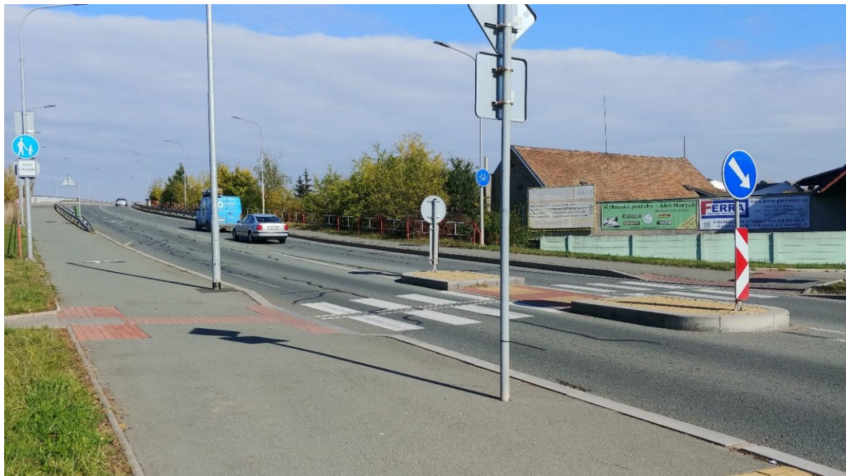
Obrázek 11 Chybné napojení cyklostezek na silnici II/333
