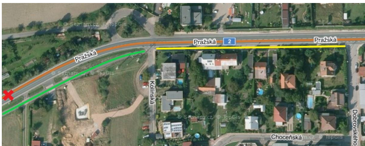
Obrázek 3 Nebezpečné místo na silnici I/2
