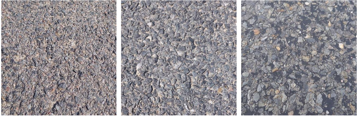
Obrázek 26: Příklad textury u různě starého nátěru. Vlevo nátěr z roku 2021, uprostřed 2018 a vpravo 2015.
