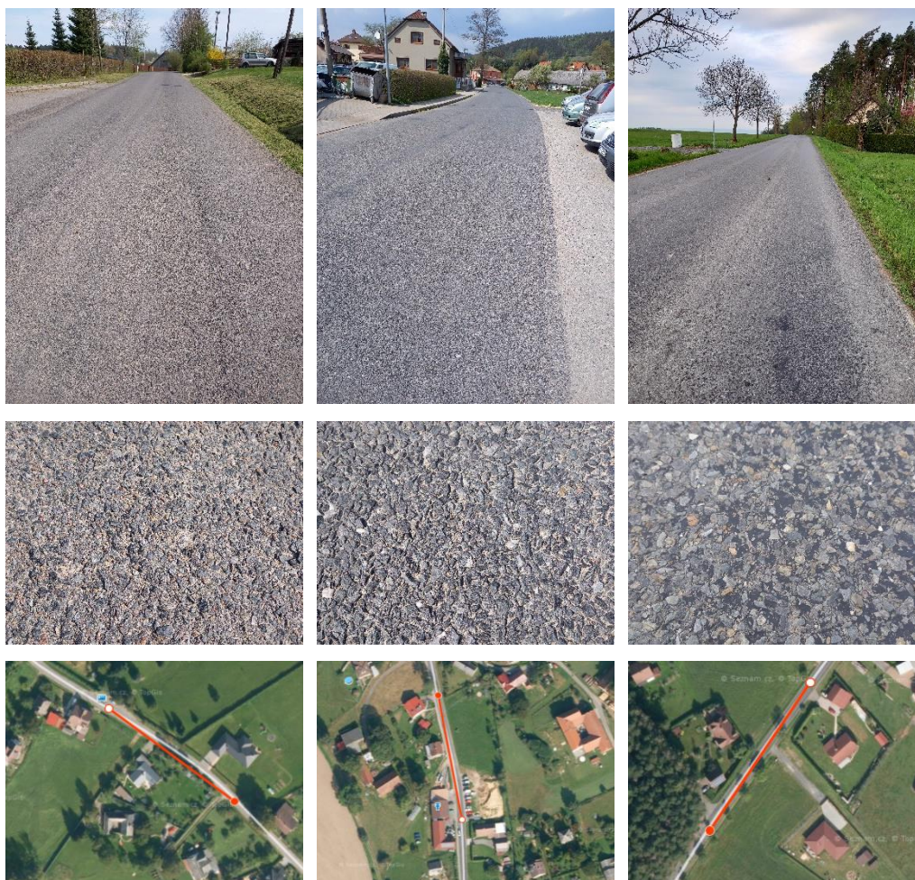
Obrázek 19: Ilustrační příklady měřených úseků, detail měřeného povrchu a jeho poloha. Vlevo úsek č.4 (2021), uprostřed úsek č. 6 (2018) a vpravo úsek č. 10 (2015) [35].
