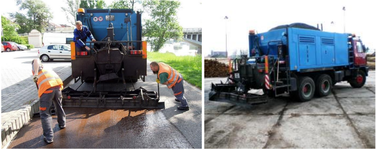
Obrázek 6: Pokládka emulzního kalového zákrytu [13]
