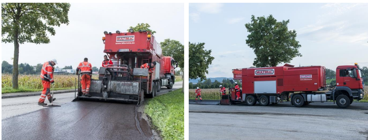
Obrázek 7: Pokládka emulzního mikrokoberce [5]
