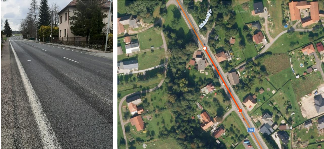
Obrázek 20: Měřený úsek silnice I/14 Libchavy s emulzním mikrokobercem [35]
