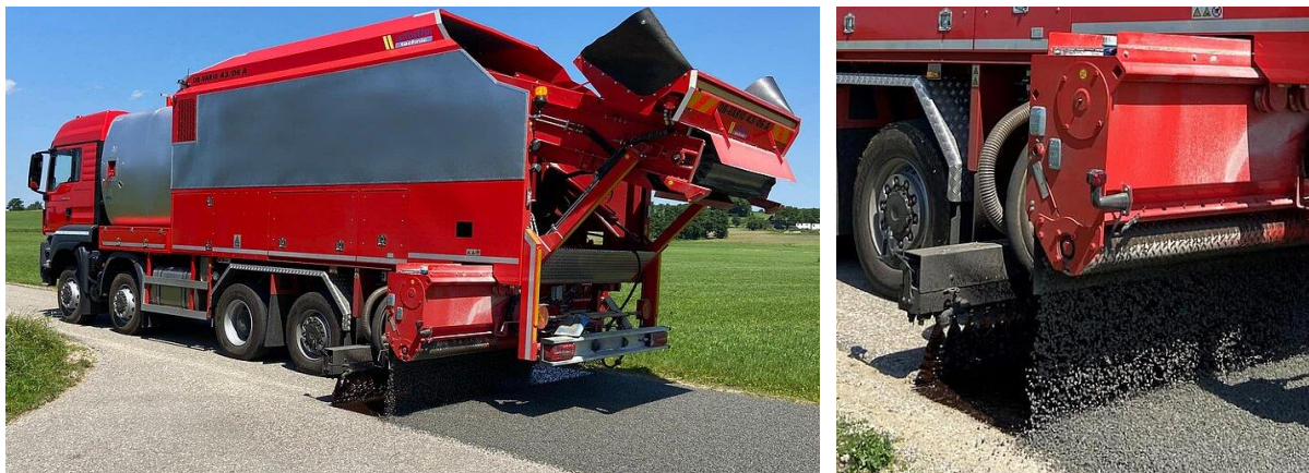
Obrázek 5: Aplikace emulzního nátěru [11]
