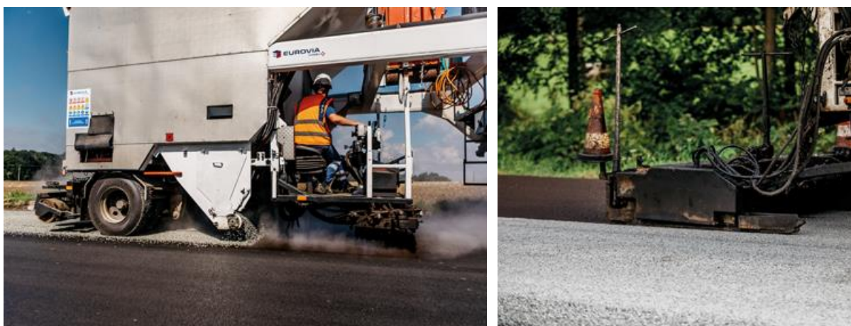
Obrázek 8: Pokládka emulzního mikrokrytu [17]
