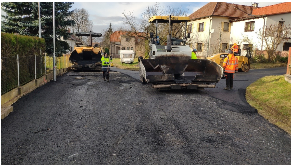
Obrázek 3: Pokládka asfaltových směsí [21]
