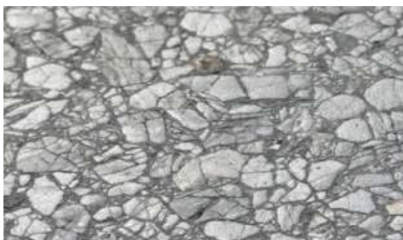
Obrázek 16: Ztráta mikrotextury [7]
