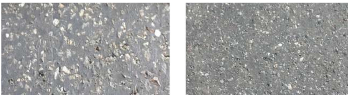
Obrázek 18: Ztráta makrotextury-detail [7]
