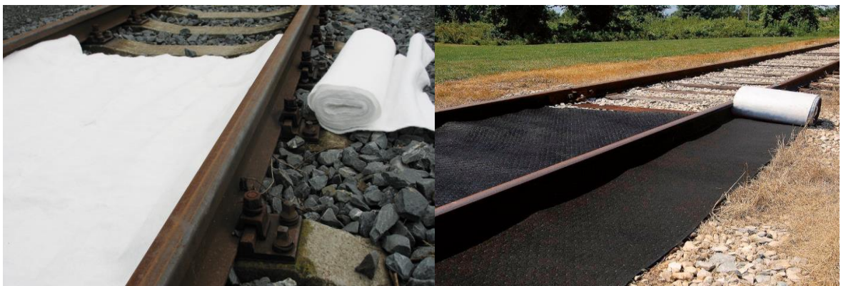
Obr. 15 Textilie do kolejiště zabraňující úniku nebezpečných látek z kolejových vozidel
