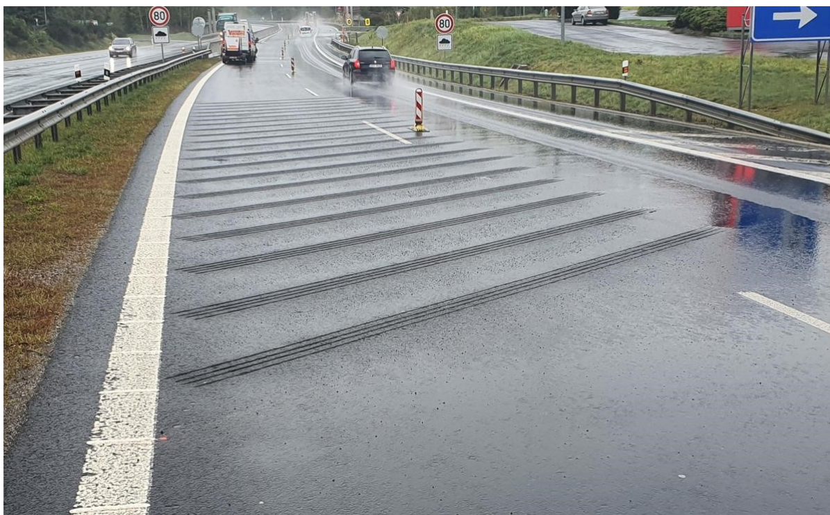
Obrázek 16 – Ukázka provedení odvodňovacích drážek [45]
