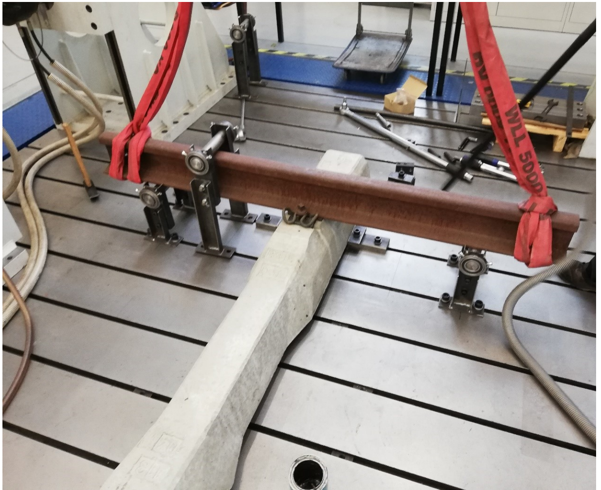
Obrázek 24: Montáž kolejnice 60E2 před experimentálními zkouškami
