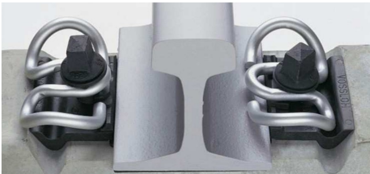
Obrázek 7: Upevnění Vossloh W 14 [4]
