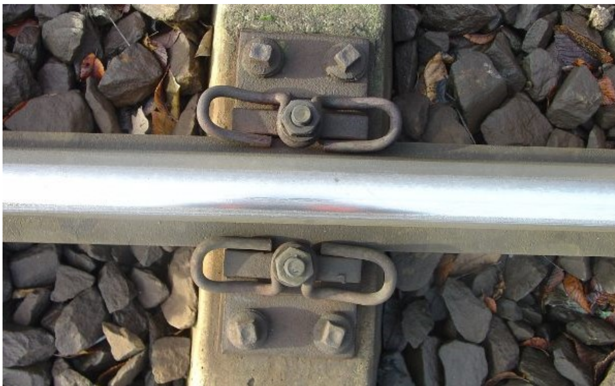
Obrázek 6: Starší upevnění KS se svěrkou Skl 24 na pražci SB 8P [6]
