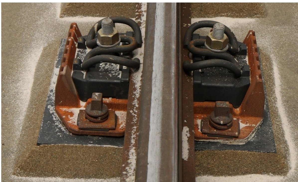
Obrázek 9: Upevnění DFF 300 používané na mostech [6]
