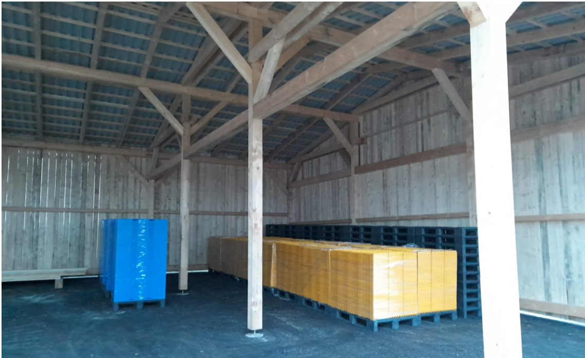
Obrázek 4 Přístavba skladu obalů (Podnik pro výrobu vajec v Kosičkách, s.r.o., 2020)
