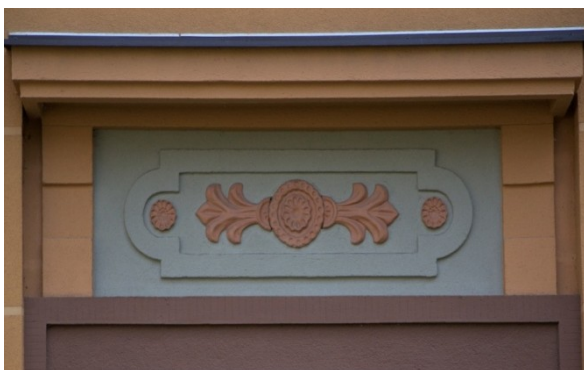
Dům č. p. 2180-2182, ulice Jiránkova
