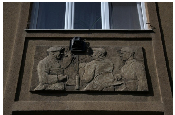
Dům č. p. 2187-2189, ulice Železničního pluku
