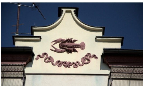
Dům č. p. 2300-2302, ulice Jiránkova
