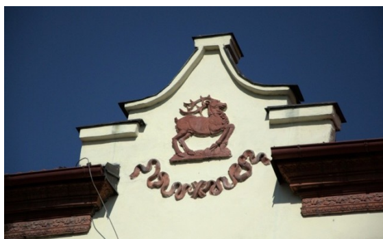
Dům č. p. 2297-2299, ulice Jiránkova
