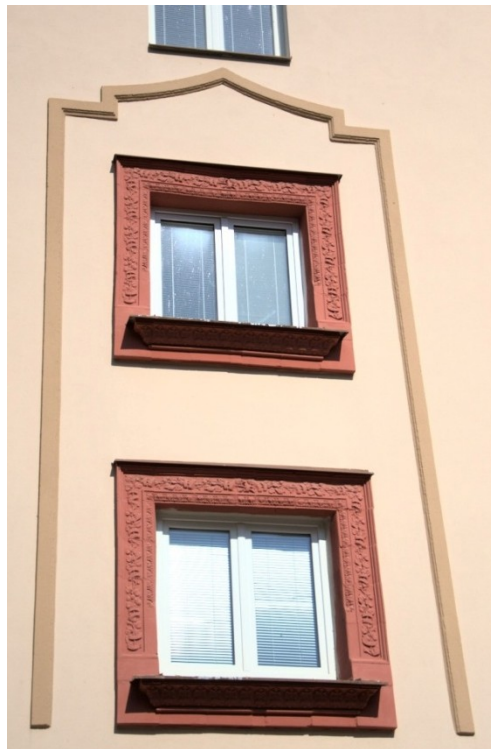
Dům č. p. 2294-2296, ulice Jiránkova
