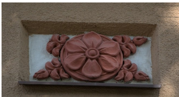
Dům č. p. 2294-2296, ulice Jiránkova
