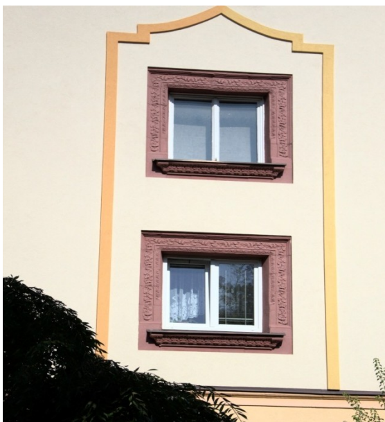
Dům č. p. 2300-2302, ulice Jiránkova
