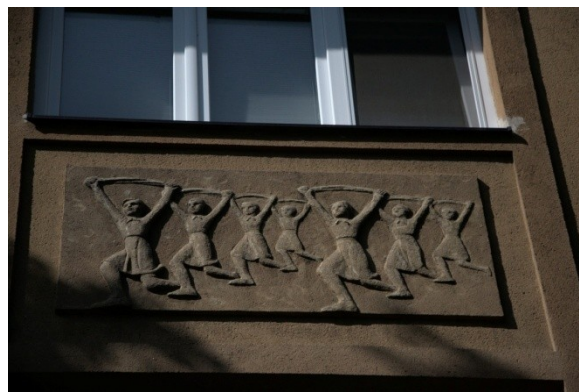
Dům č. p. 2187-2189, ulice Železničního pluku
