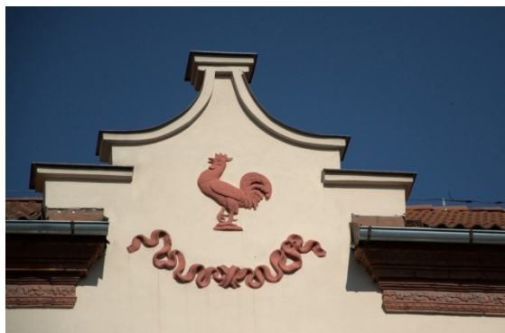
Dům č. p. 2294-2296, ulice Jiránkova
