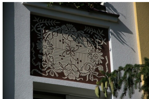
Dům č. p. 2363-2366, ulice Čs. armády
