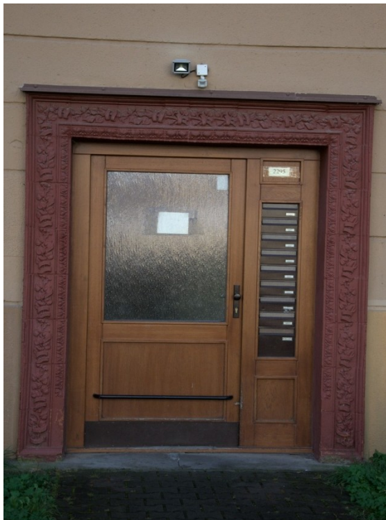
Dům č. p. 2294-2296, ulice Jiránkova
