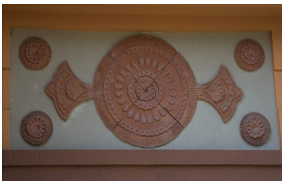
Dům č. p. 2180-2182, ulice Jiránkova
