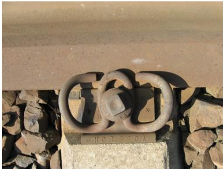
Obr. 1-14: Pružná svěrka Skl14 bez povrchové úpravy ve vzdálenosti cca 20 m od přejezdu Dobříň
