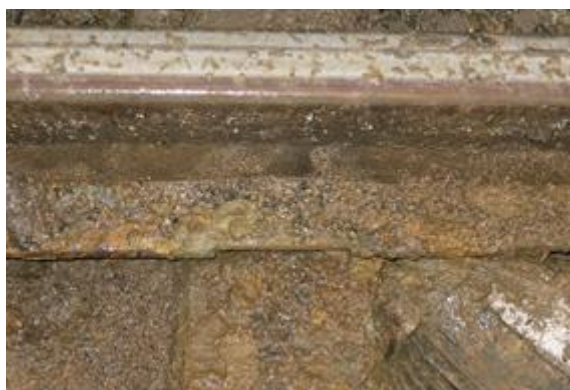
Obr. 1-4: Otlačení svěrky do panelu přejezdové konstrukce – žst. Kolín
