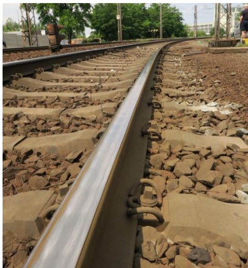
Obr. 7-72: Skluzové vlny na kolejnici
