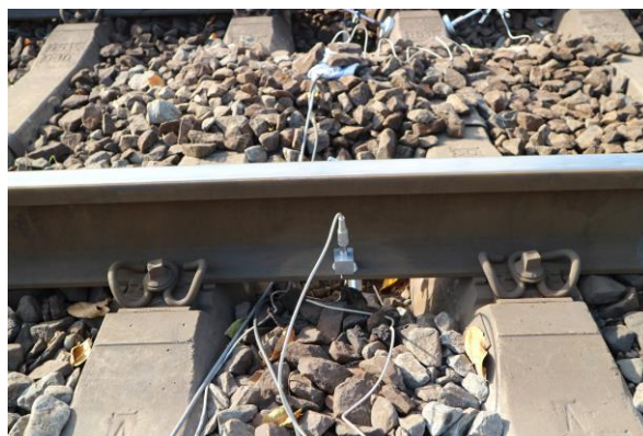
Obr. 7-67: Detail umístění snímače zrychlení
