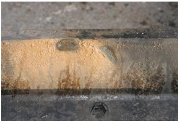
Obr. 1-19: Otláčení svěrky do panelu přejezdové konstrukce
