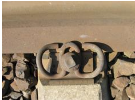
Obr. 1-7: Svěrka mimo přejezd u Dobříně
