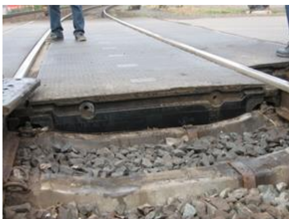
Obr. 3-3: Detail přejezdové konstrukce STRAIL
