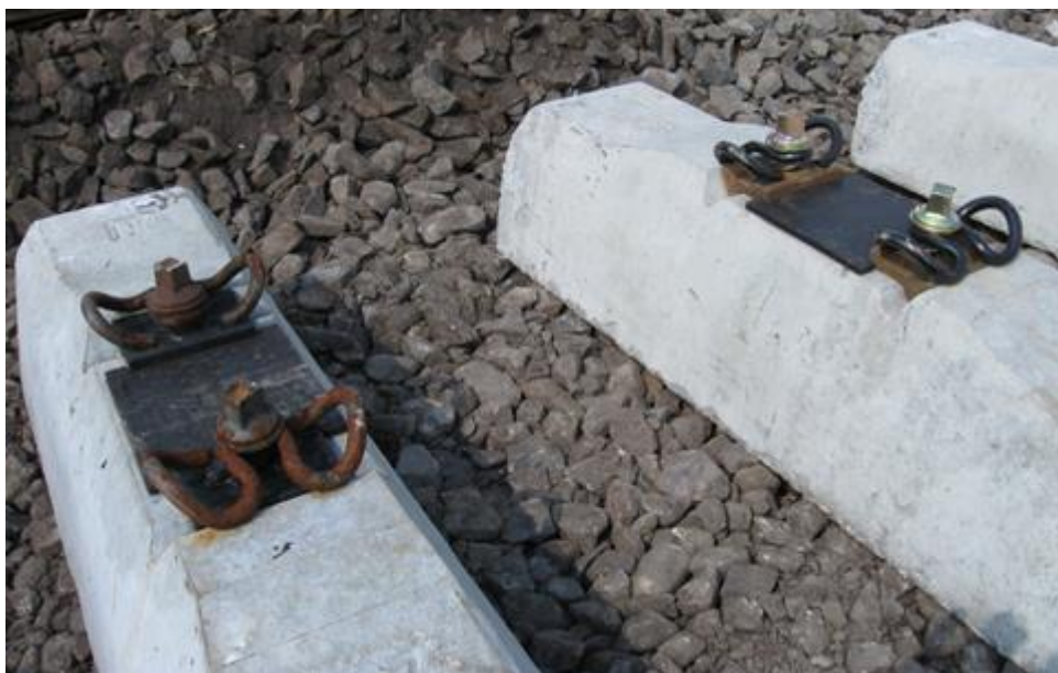
Obr. 3-1: Osazené pružné svěrky Skl14 vlevo bez povrchové úpravy, vpravo s povrchovou úpravou KTL na pražcích B91S/1 připravené k vložení kolejnice
