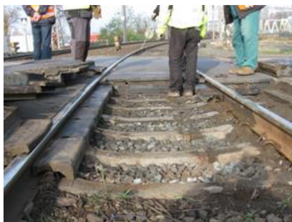
Obr. 3-4: Přejezdová konstrukce STRAIL
