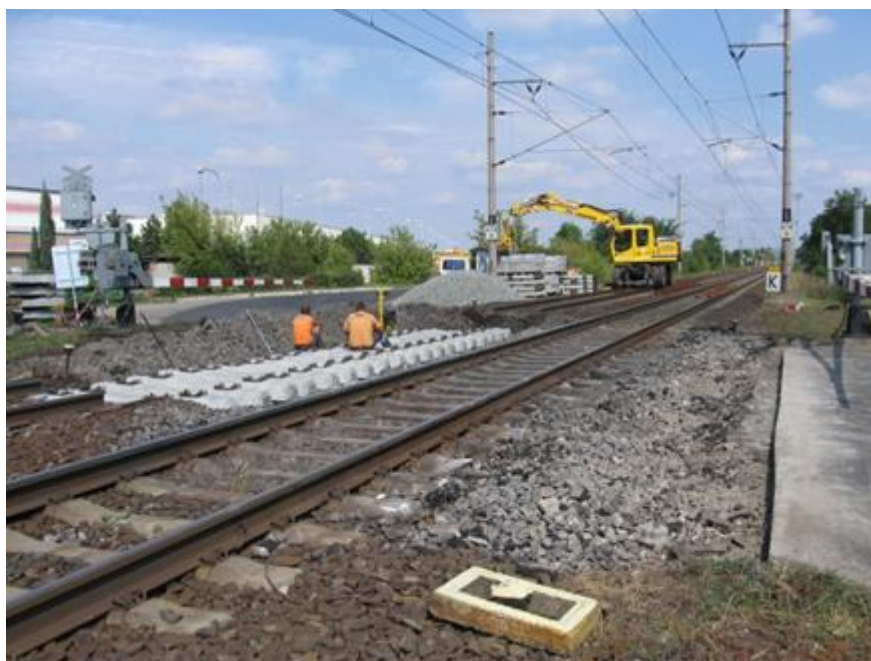
Obr. 1-12: Železniční přejezd Dobříň
