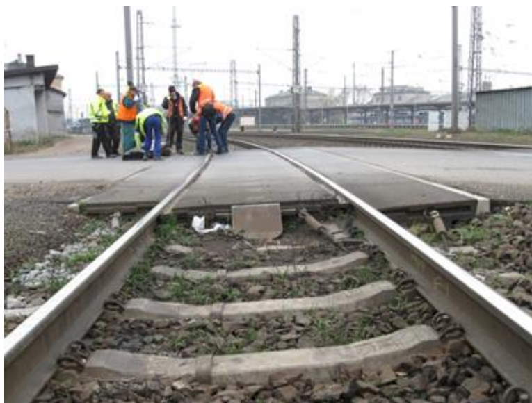
Obr. 1-16: Konstrukce železničního přejezdu v žst Kolín
