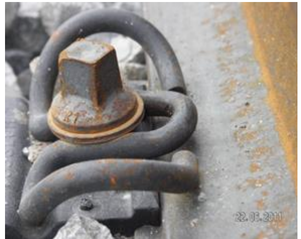
Obr. 3-10: Namontovaná svěrka Skl14 (boční pohled)
