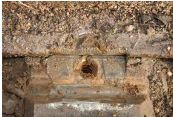
Obr. 1-22: Vzájemné opotřebování úhlové vodicí vložky a paty kolejnice
