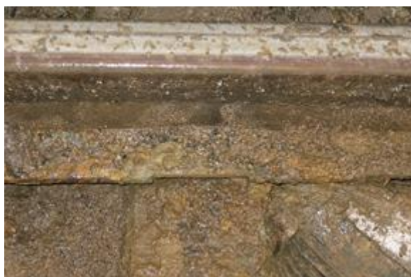
Obr. 1-3: Otisk úhlové vodicí vložky do paty kolejnice – žst. Kolín
