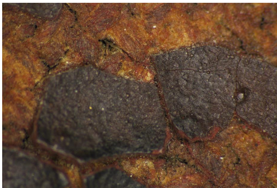
Obr. 86: Detail odpadnutí části barevné vrstvy a obnažení podkladu. 90
