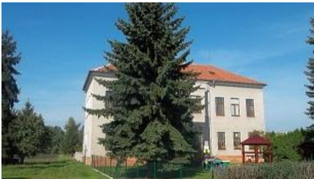
Obrázek 5 Budova Základní a mateřské školy Křečkov Zdroj: https://zsamskreckov.webnode.cz/
