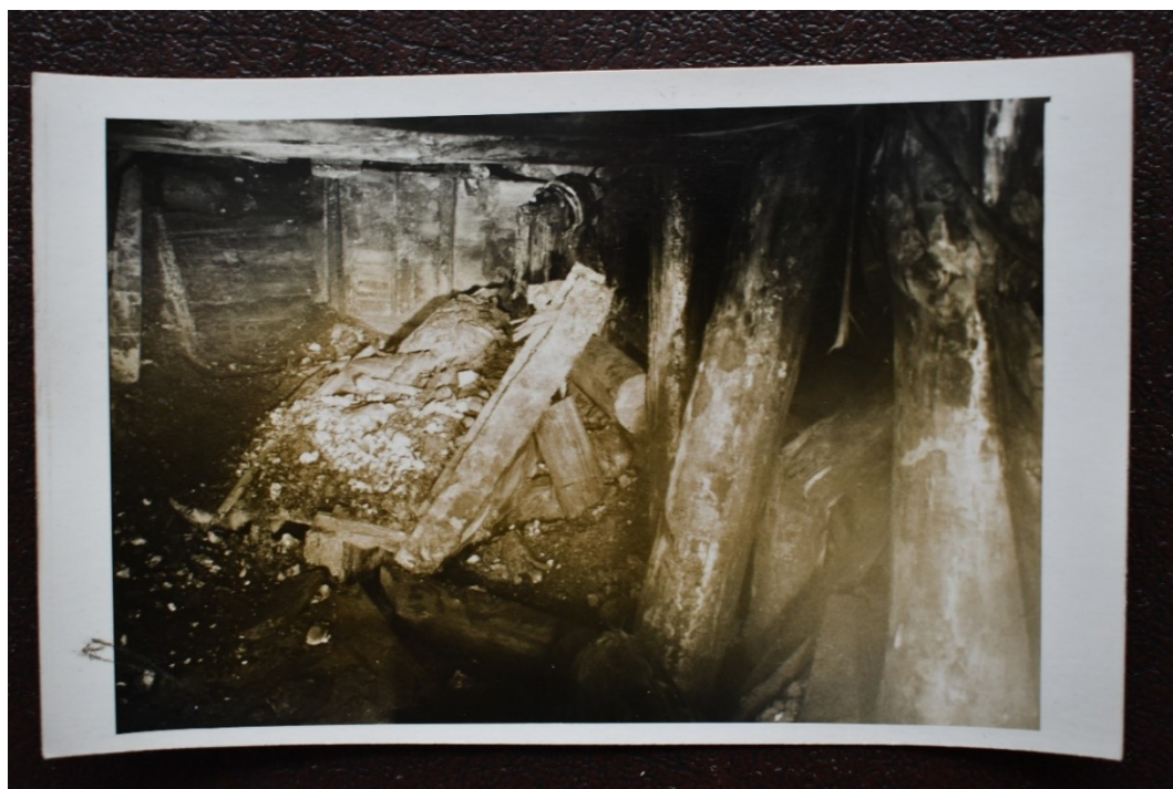
Obr. č. 9: Exploze na dole Nelson v roce 1934 (SOkA Most, Katastrofa na dole Nelson III v roce 1934).
