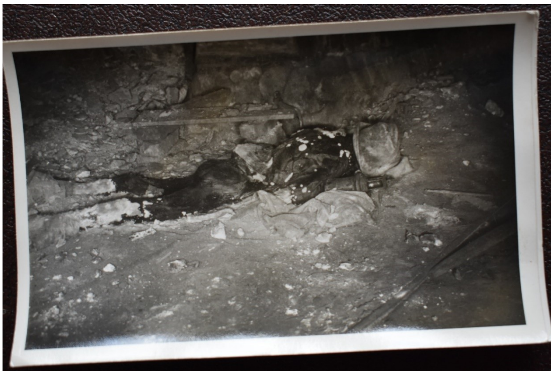
Obr. č. 7: Exploze na dole Nelson v roce 1934 (SOkA Most, Katastrofa na dole Nelson III v roce 1934).
