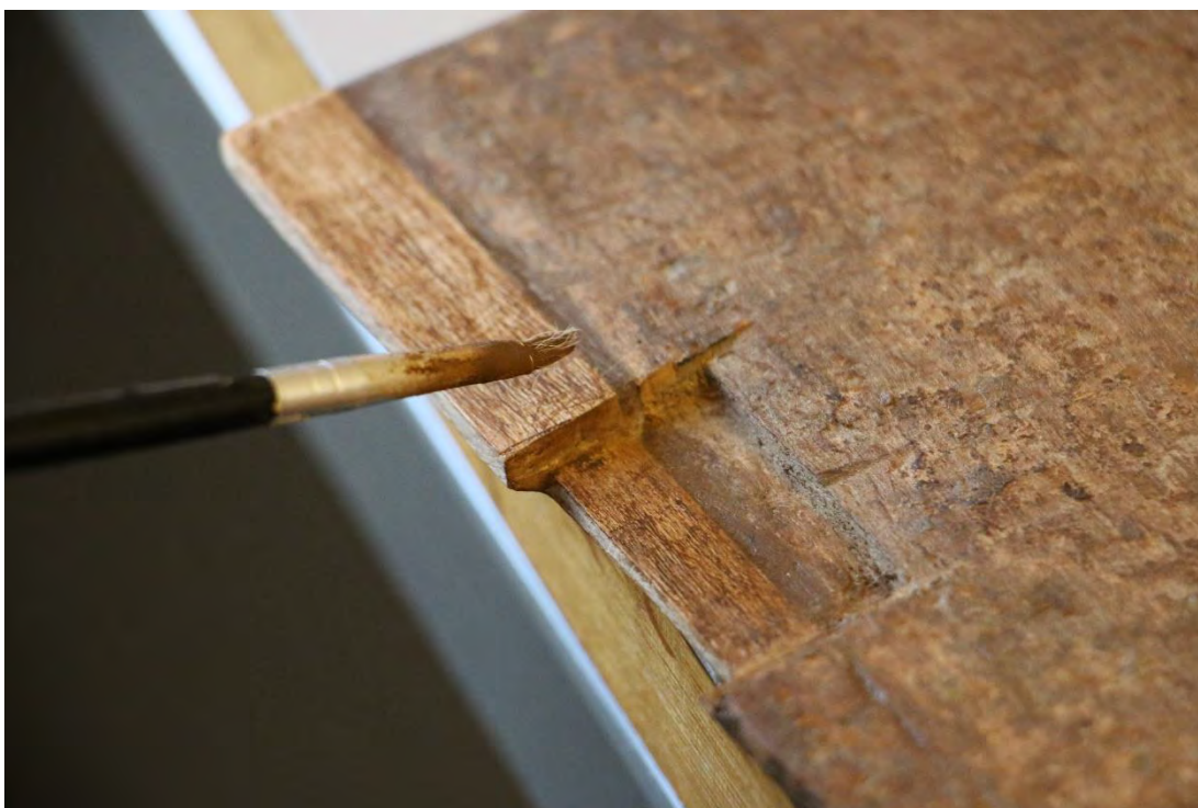
18 Obrázek 46 Tónování dřevěného doplňku včelím voskem v benzínu s pigmenty
