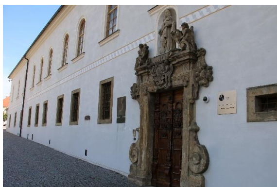
Obr. 203 Severozápadní strana piaristické koleje v Litomyšli (Fakulta restaurování Univerzity Pardubice)
