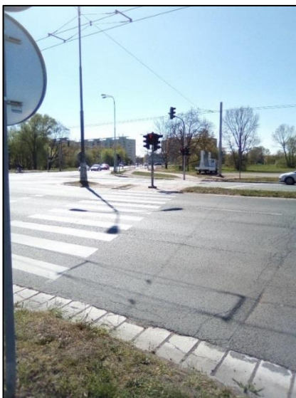
Obrázek 32 Mileta - přechod a přejezd č. 2
