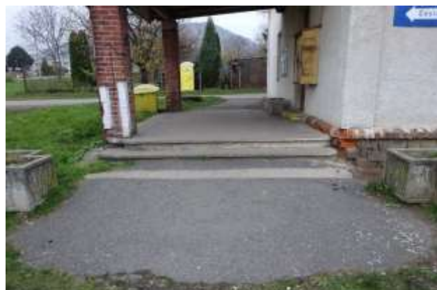
Obrázek 4 Příchod k nádražní budově
