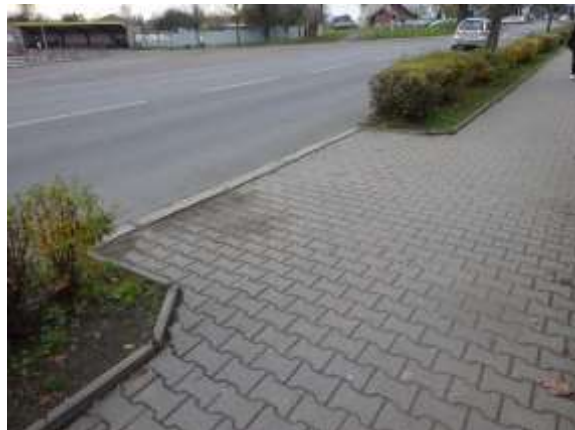
Obrázek 5 Pohled na snížený obrubník, chybí zde varovný pás Zdroj: autor
