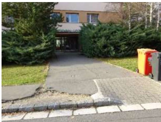
Obrázek 33 Hlavní vstup do budovy zdravotního střediska
