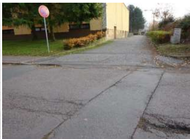
Obrázek 22 Pohled na vjezd k zadnímu traktu kulturního domu Zdroj: autor
