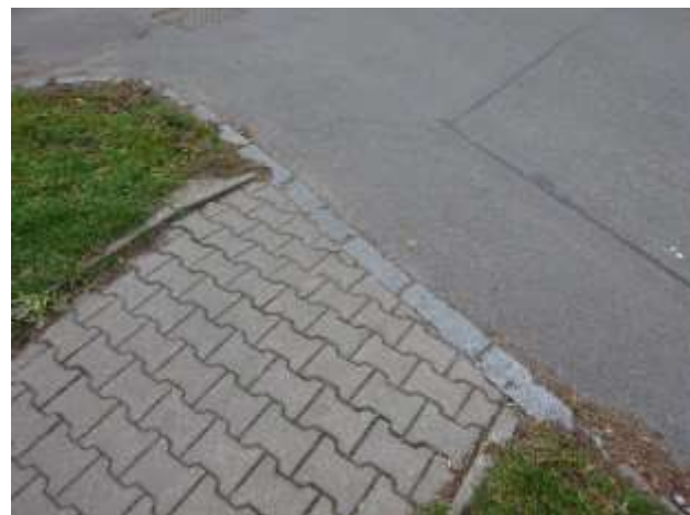
Obrázek 10 Místo pro přecházení, chybí varovný a signální pás Zdroj: autor
