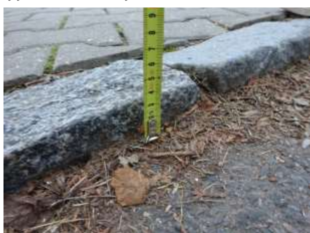
Obrázek 8 Výška obrubníku u místa pro přecházení: 4 cm Zdroj: autor
