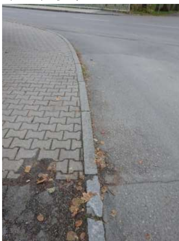
Obrázek 10 Místo pro přecházení, chybí varovný a signální pás Zdroj: autor
