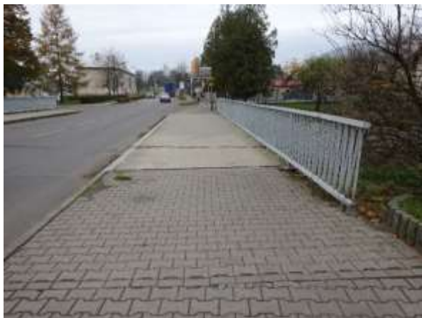
Obrázek 122 Pohled na most ev. č. 33741-1 Zdroj: autor
