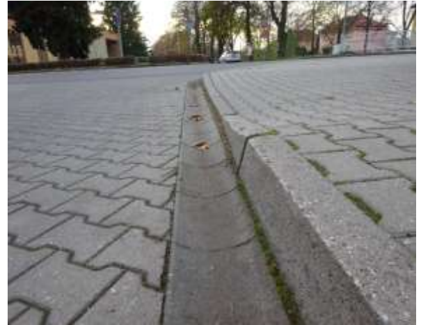
Obrázek 17 Detail kanálku tvořící bariéru Zdroj: autor
